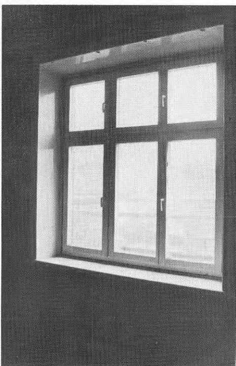
FIG 5.5 Ny dörr i stark kontrast till kakelugnens detaljrikedom. Ursprungliga fönstersnickerier med enkla bågar utbyttes mot nya kraftiga instickskarmar med kopplade bågar
