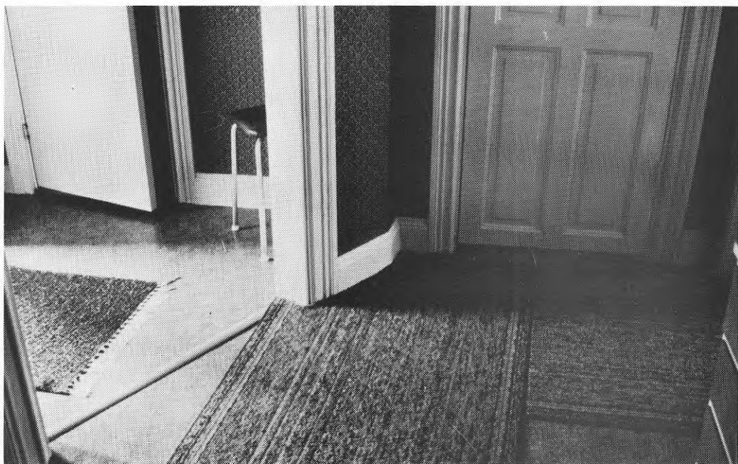
FIG 5.6 Trösklar. Ektröskel mellan furugolv. Halvrund plastlist över skarven mellan golvmaterialet
