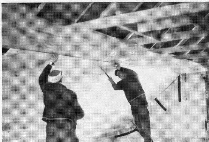
FIG 62 Hus 9-12. Obruten plast- folie på olika ytor.
