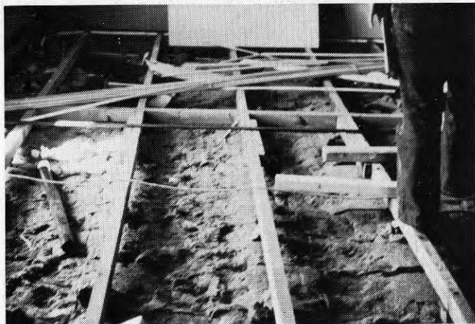
FIG 29 Hus 1, 2. Mineralull i golv som lagts ut för tidigt, och som till stora delar trampades ihop.
