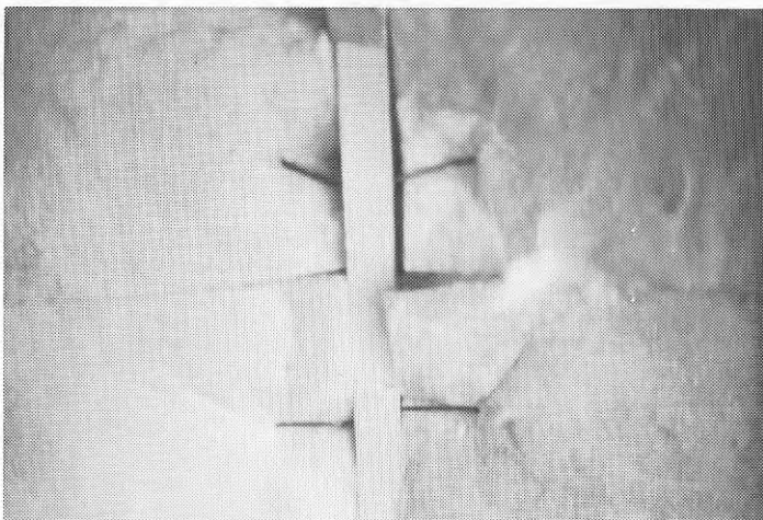
FIG 43 Hus 9-12. Upphängning av mineralull i snedtak med spikar. Tveksam lösning.
