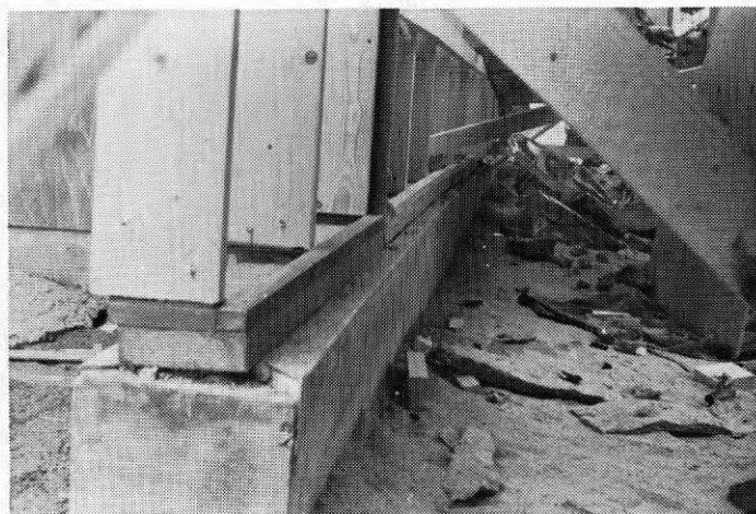
FIG 30 Hus 2. Genom den felaktiga bredden på grundplattan och genom att man inte använde de speciella hörnelement som finns för kantisoleringen fick man svårt att klara denna isolering på ett bra sätt.
