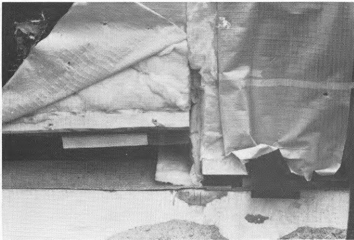
FIG 54 Hus 5, 6. Tätning mellan polymer. Vindskyddet av armerad, punkterad folie viks väl om lott och kläm fast.
