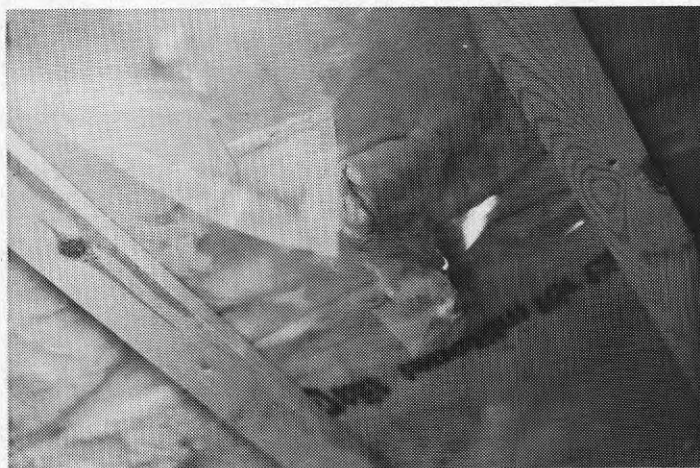
FIG 70 Hus 13, 14. Folie sönderskuren för att vatten i isoleringen skulle torka ut.
