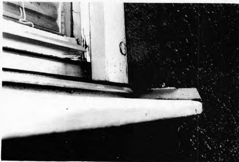
Bild 9. Rundlagning av kvist i mycket olämplig del av fönstret.
