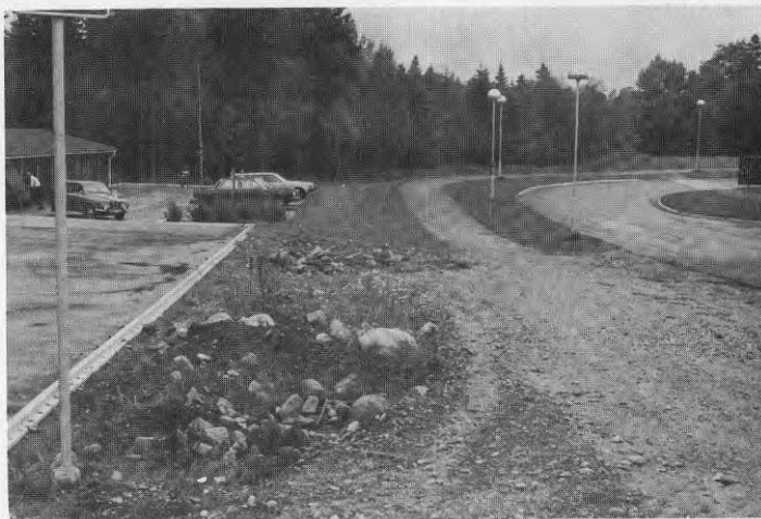
Fig. 8.5. Avgränsningen mellan kommunens mark och sam- fällighetens mark är viktig. Vem har intresse av att sköta slänter? (kv. Hulta i Borås)
