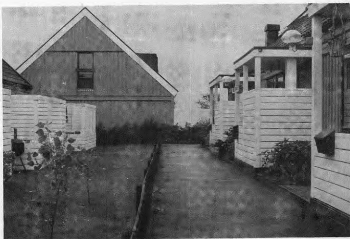
Fig. 10.9.a,b. Detaljer i utformningen, såsom entréer mot baksidor.....
