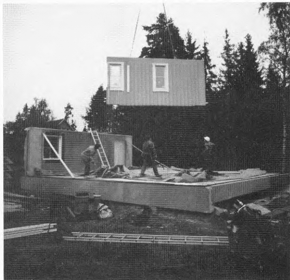
Bild 3.2 C Montering av väggelement.
