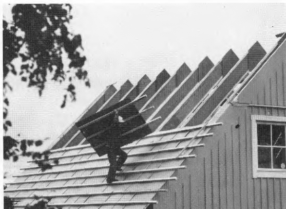
Bild 3.2 D Montering av takluckor på takstolar.
