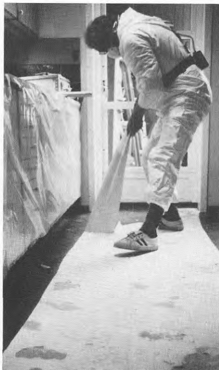
Bild 11 Utrivning av plastmatta med latexbunden asbestbaksida, limmad på spånskiveunderlag. Mattan delar sig i skum- resp pappskiktet.
