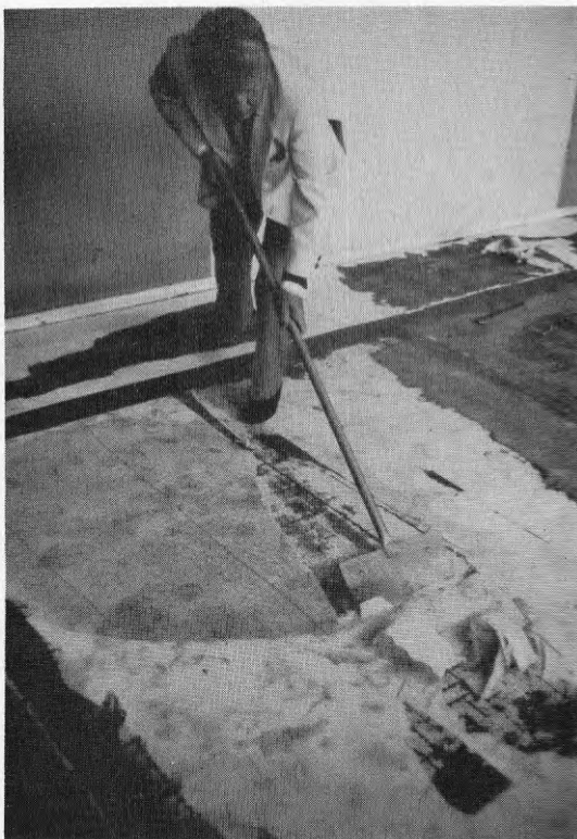
Bild 1 Golvskrapa. Rensning av PVC-skumrester på plastbeläggning.
