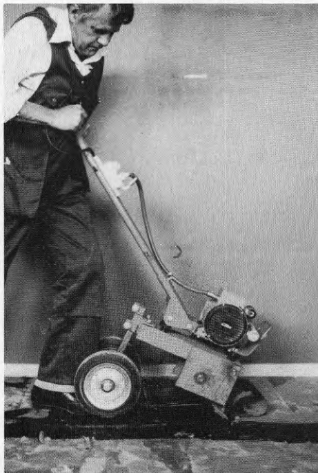
Bild 7 Hjulstripper . Rensning av asfaltimpregnerad papp på betong.
