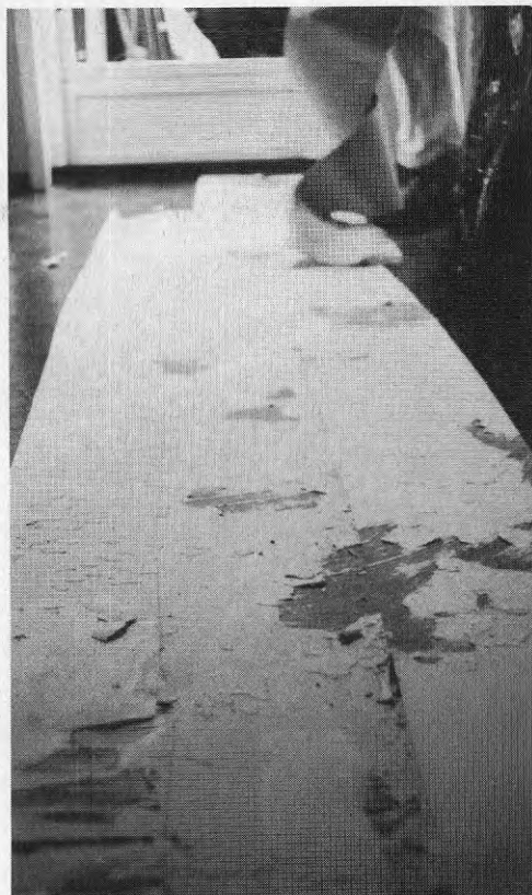
Bild 13 (nedan) Handstripper . Rensning av kvarsittande skum- och asbestrester. Mätning av asbestfibrer i luften pågår.
