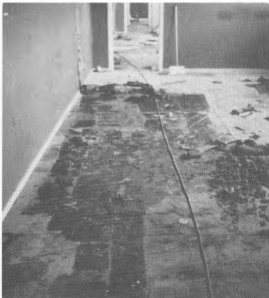
Bild 15 Resultat av rensning av papprester med hjulstripper
