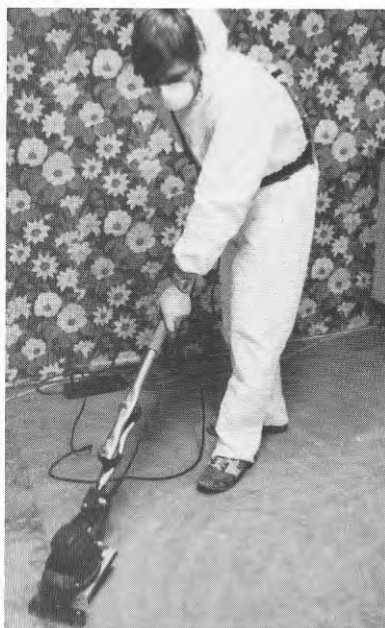
Bild 3 Handstripper med skaft. Rensning av latexbunden asbest- på träfiberskiva
