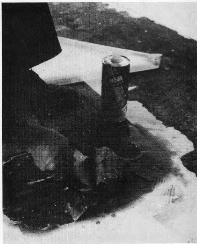
Bild 17 Mindre prov med upp- lösningsvätska. Bort- tagning av latexbun- den asbestpapp på betongunderlag.
