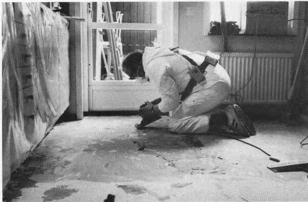
Bild 13 (nedan) Handstripper . Rensning av kvarsittande skum- och asbestrester. Mätning av asbestfibrer i luften pågår.
