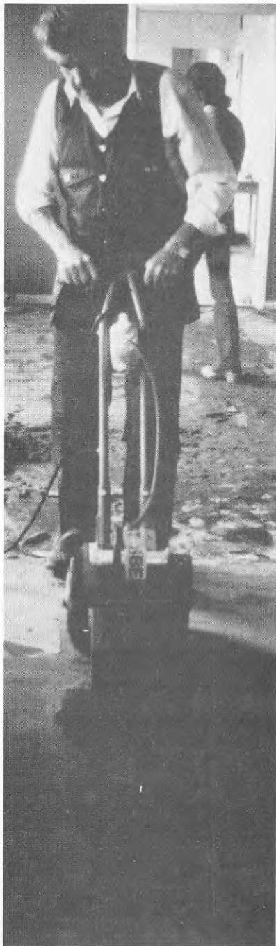
Bild 16 Hjulstripper . Rensning av papp- rester efter utrivning av lino- leum.
