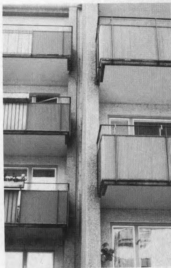
Figur 26 och 27. Trots stora ojämna sättningar i husen i kv Steglitzan har endast obetydliga skador uppkommit i husen. Se bilden till höger.
