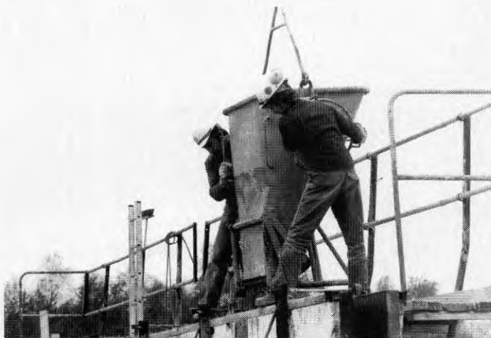
Figur 2:2:2:1 Väggjutning med den gamla 0,45 \text{ m}^3 :s basken.
