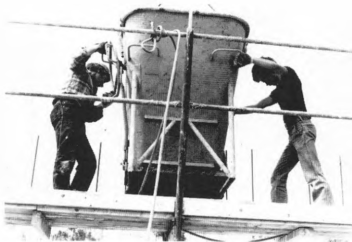
Figur 2:3:2 Väggjutning med flytbetong etapp 2.
