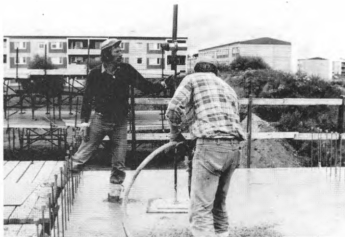
Figur 2:2:4:1 Kontroll av gjuthöjd.
