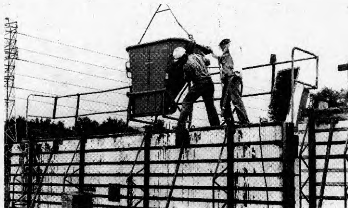
Figur 2:3:3 Väggjutning under etapp 3.
