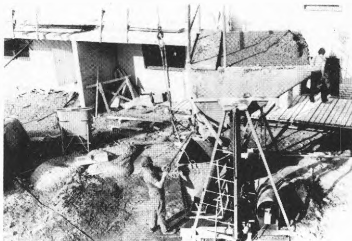
Figur 2:2:1:1 Arbetet vid den gamla betongfickan.
