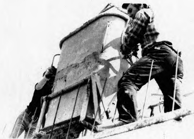
Figur 2:3:1 Väggtutning med normalbetong.
