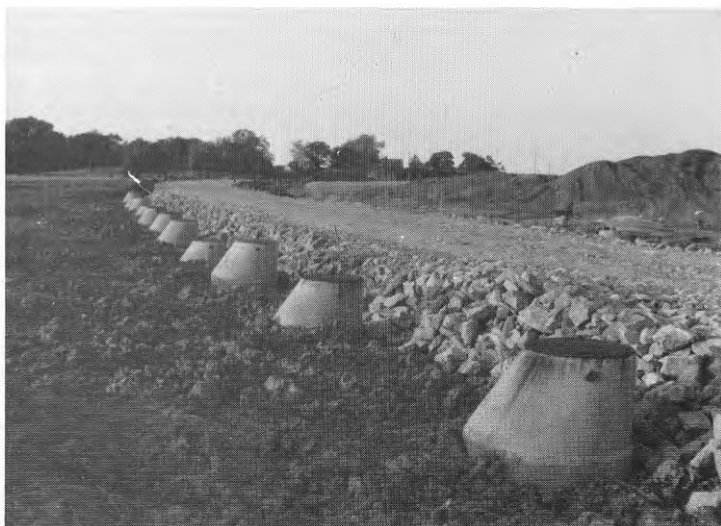
Återfyllning och vägöverbyggnad klar. Beläggningen ännu ej utförd.
