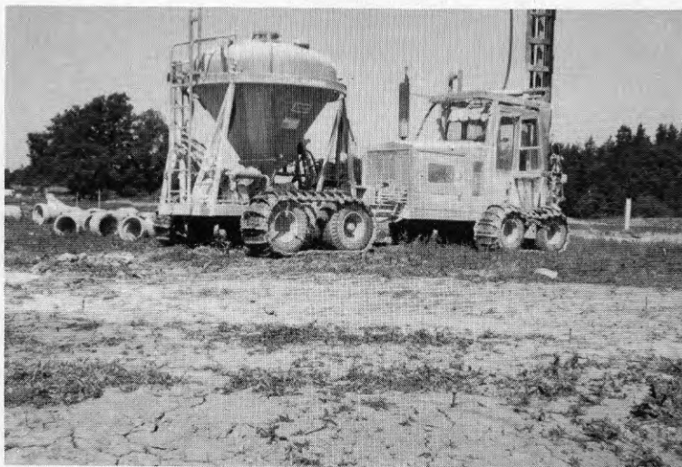
Figur 25 Kalkpelarsättning med LPS-3 i Glömsta, Eskilstuna
