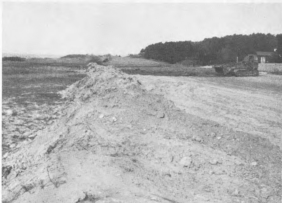
Efter återfyllning schaktas avtagningsmassorna tillbaka. Foto: Hans Leibel
