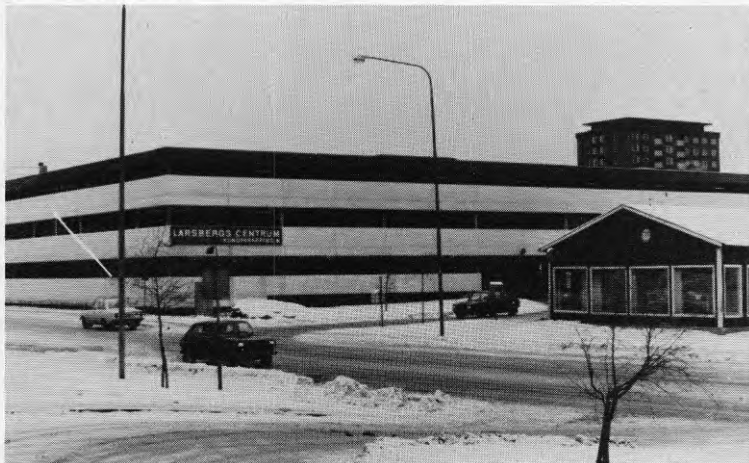
Figur 7. Parkeringshus vid Larsbergs centrum.
