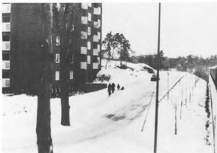
Figur 17. Till höger parkeringshuset och till vänster punkthuset med undercentralen. Ledningarna mellan husen dras i kulvert som måste ny-anläggas.
