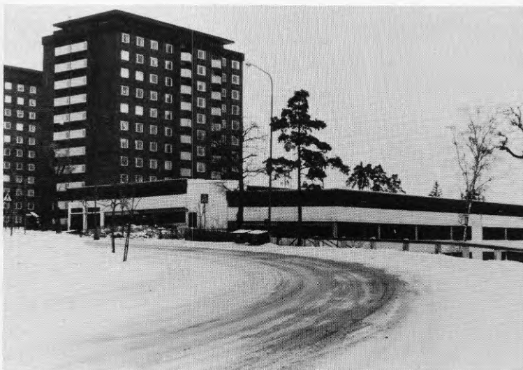
Figur 8. Parkeringshus i Östra Larsberg
