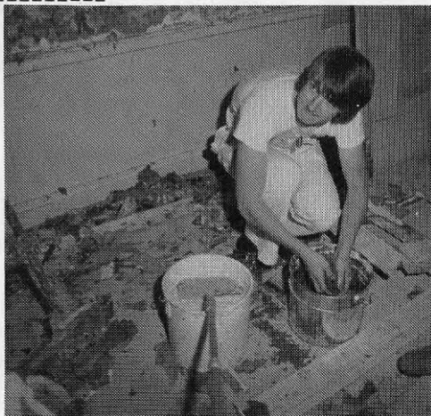
Fig.11. Målarna använder vanligt tapetklister som rollas utanpå de gamla tapeterna. Byggplast fästs utanpå detta. Fukten tränger då in i tapeten och mjukar upp det gamla klistret.
