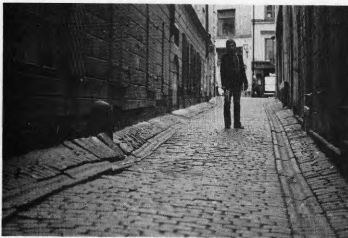
Fig 70. Gatstenarna hänger kvar på husfasaderna när marksättningarna är större än hussättningarna (Bedoirsgränd).
