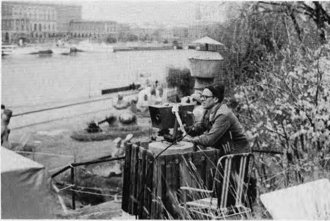
Fig 3. Mekometermätning från instrumentpunkten på Skeppsholmen.
