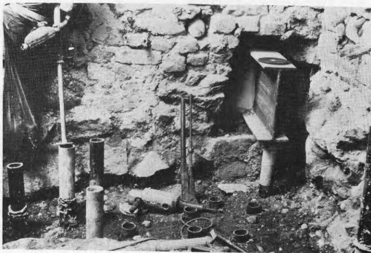
Fig 99. Stålplastpålar vid balkände före gjutning.
