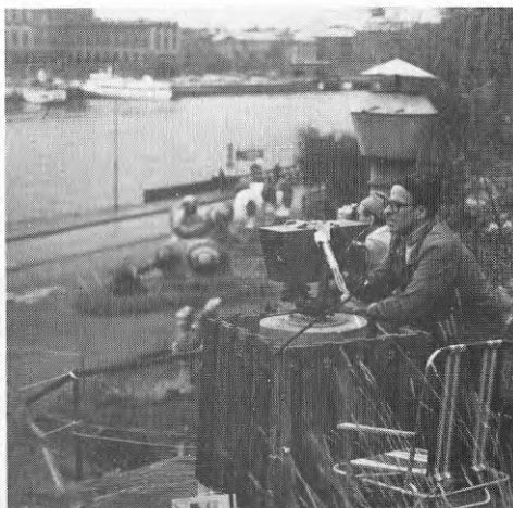
Fig 52. G Galvenius mäter med Mekometer.
