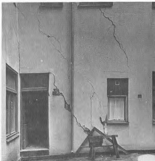
Fig 83. Sättningssprickor på gårdsfasad. Thisbe nr 4
