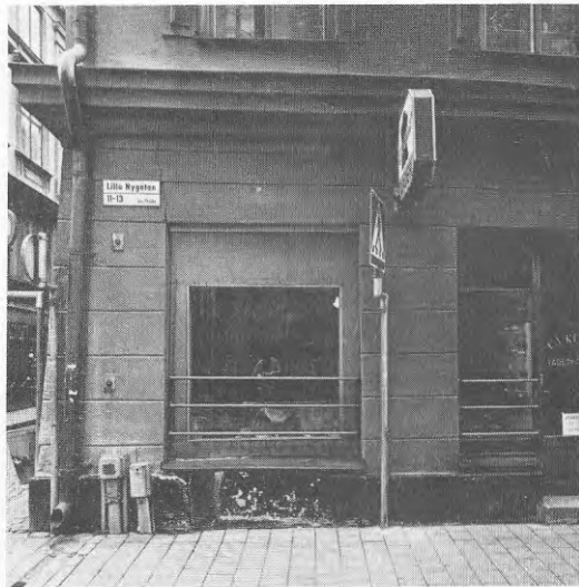
Fig 77. Sättningsprickor i gatufasad. Skyltfönstret har måst ersättas med träfiberskivor till viss del. Thisbe nr 4
