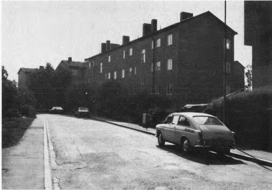
FIG 2.7-1 Exteriör mot gata och entresida.
