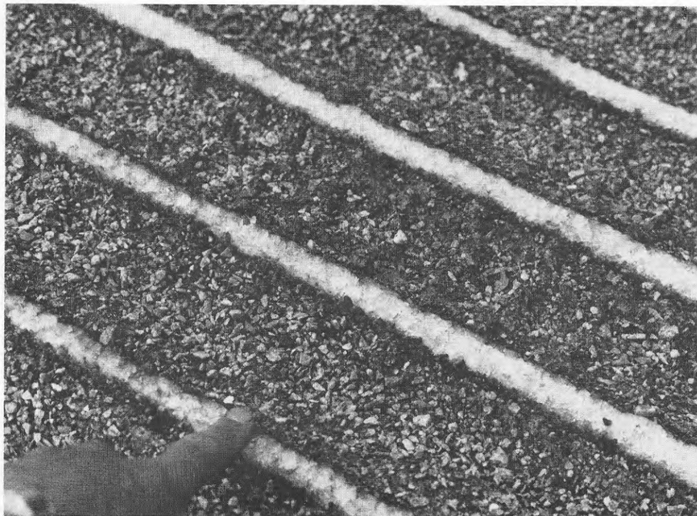
Figur 3.7. Kylrören i bandybanan när provdriften avslutades den 9 maj kl 15
