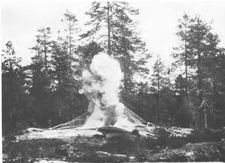
Figur 6.3 Genomslag vid för hög laddningskoncentration, vid lätt täckning.
