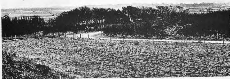
Fig 1. Efter nedgrävning av naturgasledning återställs marken
