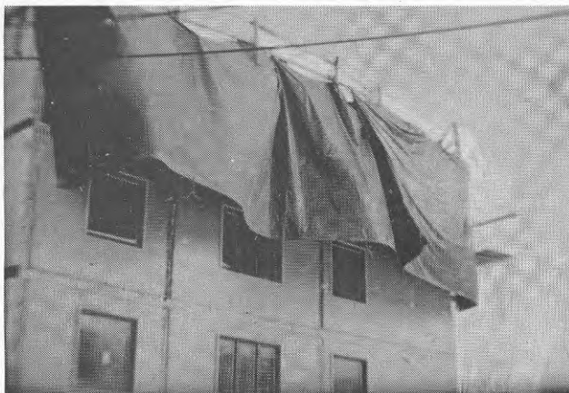
Fig. 13. Den vanliga metoden med presenningar för intäckning av fasaden.
