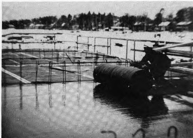
Fig. 14. Snabb utrullning av isolermatta på nygjutet betongvalv.
