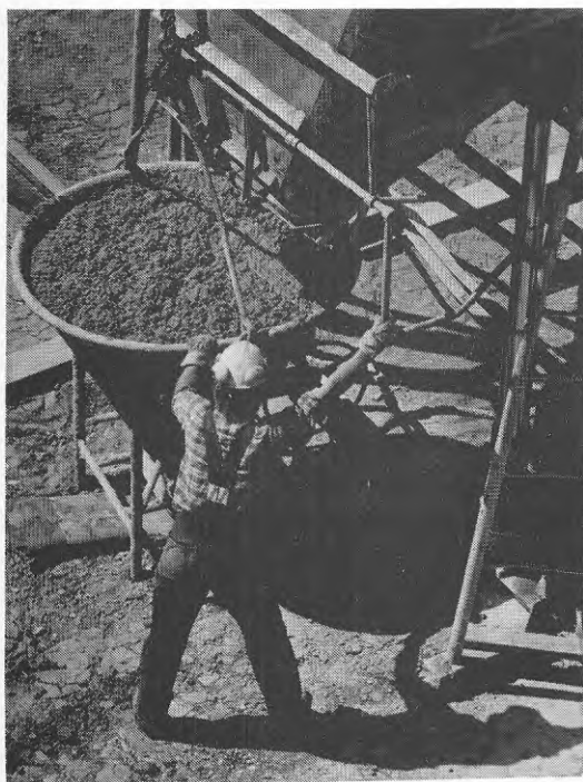
Fig. 5. Ett arbetsmoment för betongarbetaren.
