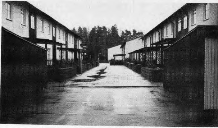
Figur 8. Den pålade plattans begränsningslinje framträder på grund av marksättningar.
