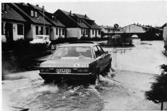
Figur 11. Överbelastat perkolationsmagasin.
