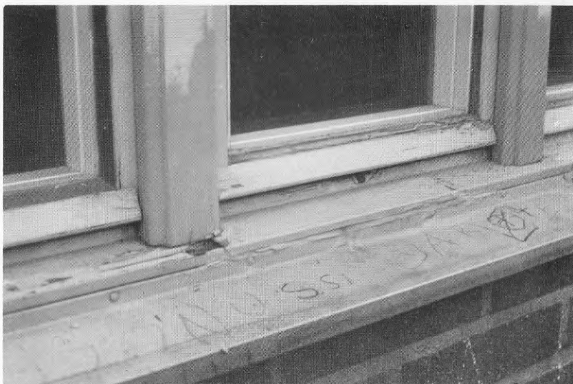
Felaktig åtgärd: Övermålade rötställen påskyndar rötans fortskridande.
