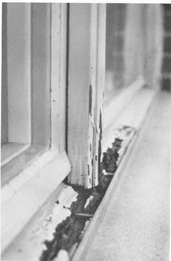
Långt framskriden röta hos karmbottenstycke.
