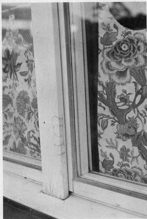
Kvistpluggar under målningen på fönsterpost. De brukar bli synliga redan efter ett år.
