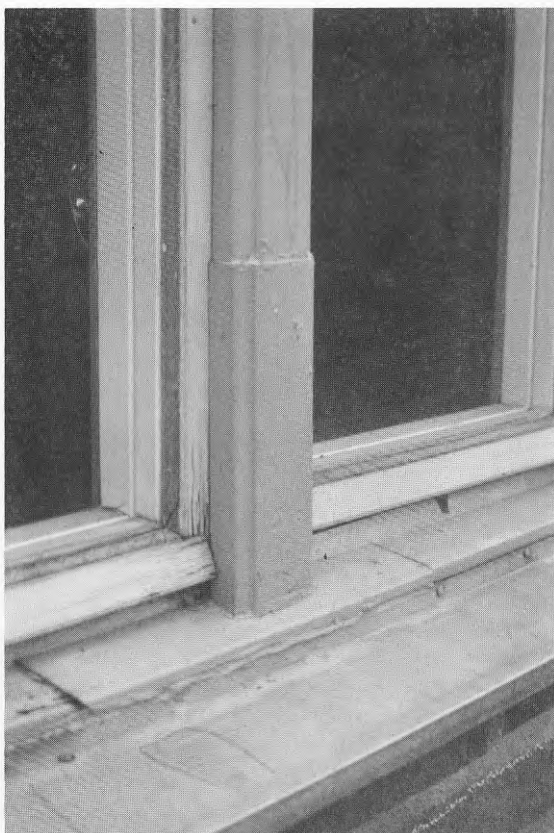
Felaktig åtgärd: Utbytta delar av karmen ger nya angreppspunkter för rötan i skarvarna.
