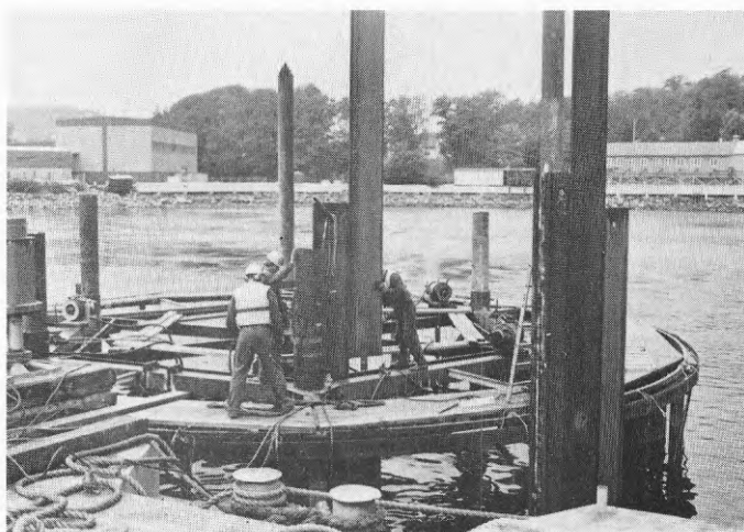
Figur 3.7 Två spontplankor sätts ihop innan de monteras i spontväggen.
