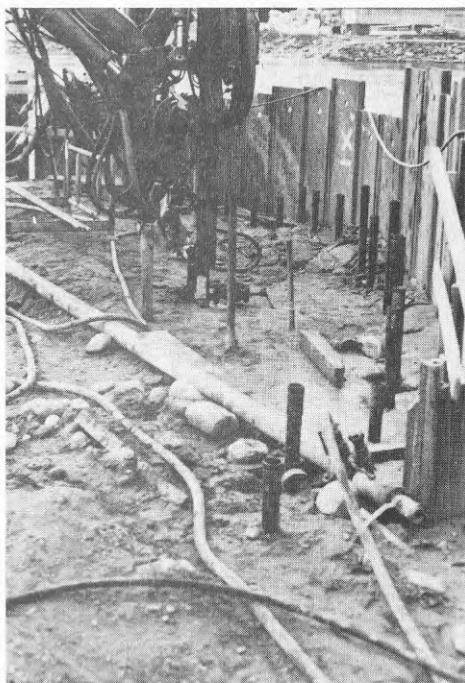
Figur 3.28 Borrhål för injektering.
