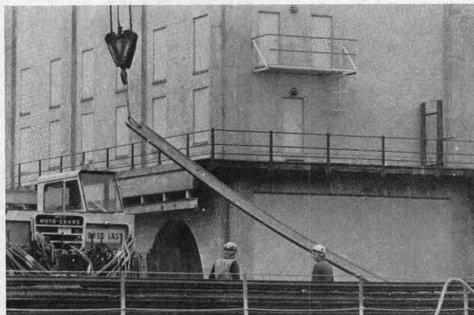
Figur 3.6 Spontplankorna lyftes med en fästpunkt vid spontsättningen.
