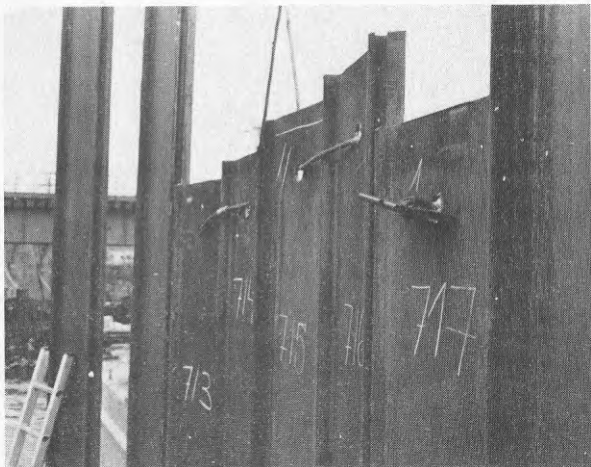
Figur 3.10 För att få ner sista spontplankan lyfte man upp fyra ä fem spontplankor i anslutning till densamma.
