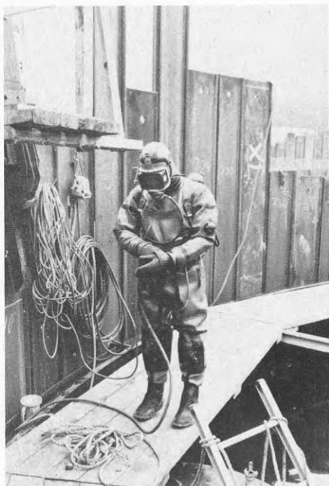
Figur 3.12 Dykaren på väg att gå ner och kontrollera spontplankorna och ta bort den undre styrningen.
