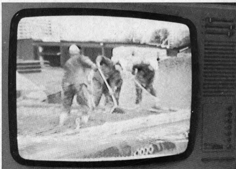
Figur 3 Gjutning av bottenplatta för småhus. Fördelning av normalbetong med skyffel efter utportionering med bask.
