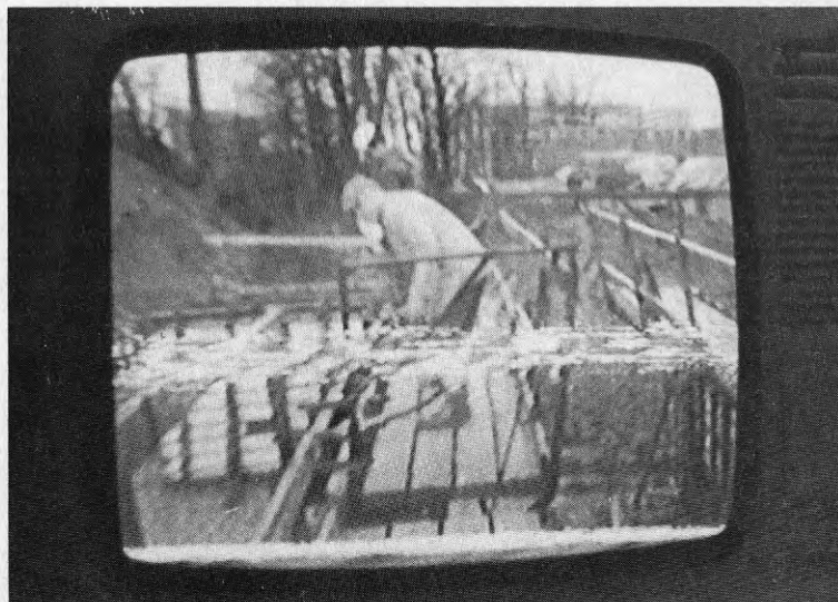
Figur 7 Gjutning av vägg med normalbetong, vibreringsarbete.
