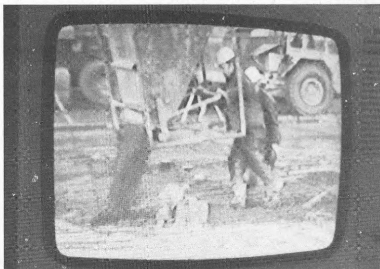
Figur 5 Gjutning med bask, flytbetong.
