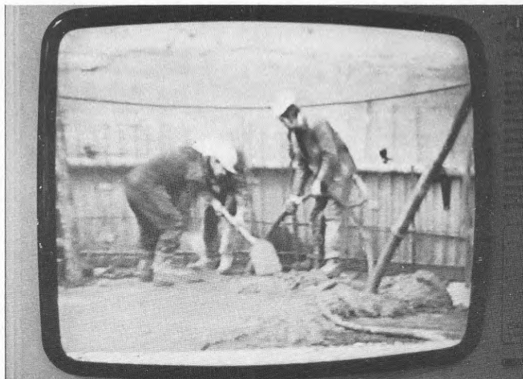
Figur 1 Gjutning av motviktsplatta, betongpumpning. Fördelning av normalbetong med skyffel samt vibrering med vibrostav.
