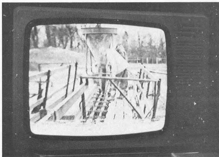
Figur 6 Gjutning av vägg med flytbetong, hantering av tratt.
