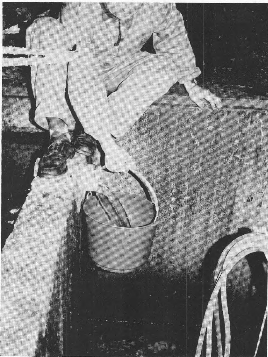
FOTO 4. LÄCKVATTENMÄTNING MED 15 l MÄTKÄRL I PUMPGROP.
