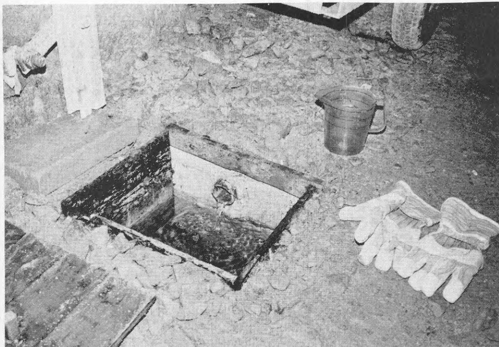
FOTO 2. MÄTDAMM FÖR MÄTNING AV INLÄCKANDE VATTEN.
