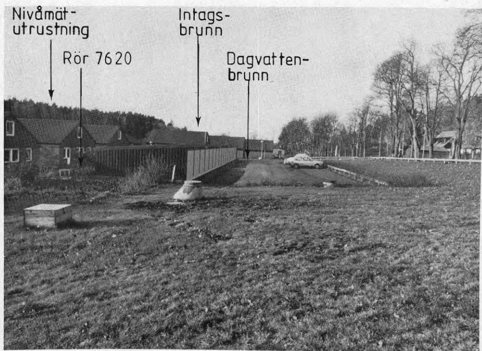
Fig. 5.1.1d Perkolationsmagasin Tullinge gård (fr.nordost)
