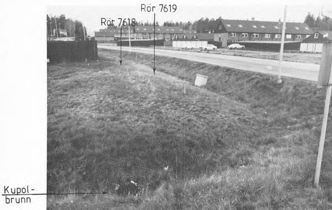
Fig. 5.1.2c Infiltrationsyta Tullinge gård (fr.sydost)
