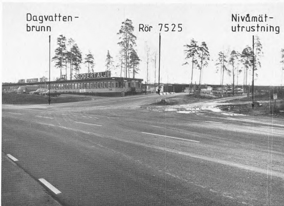
Fig. 5.2.1d Perkolationsmagasin Södertälje Sydhamn (fr.väster)
