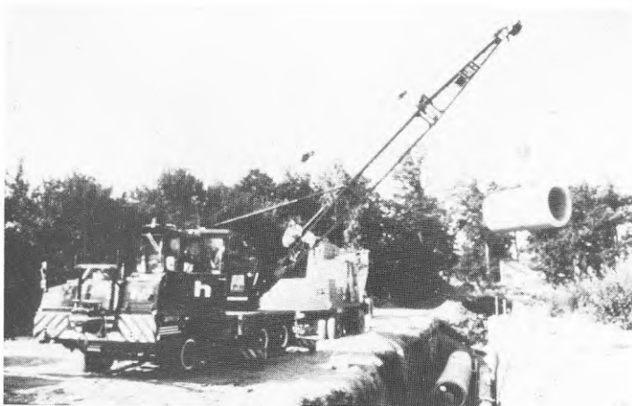
FIG. 34 Rörläggning i kalkpelarförstärkt schaktgrav.
