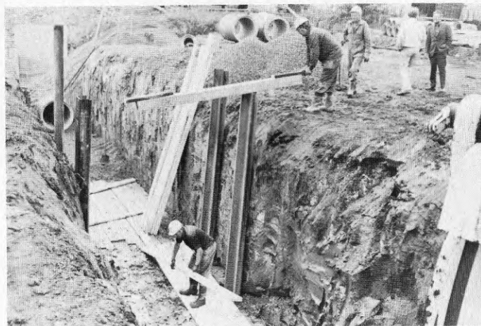
FIG. 35 Kalkpelarförstärkt rörgrav under vändplan, djup 3,5 m.
