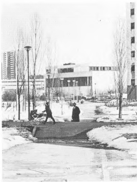
FIG. 3 Etappvis uppfyllning av mark intill pålat hus. Puckeln i förgrunden orsakad av ledning grundlagd på pålar
