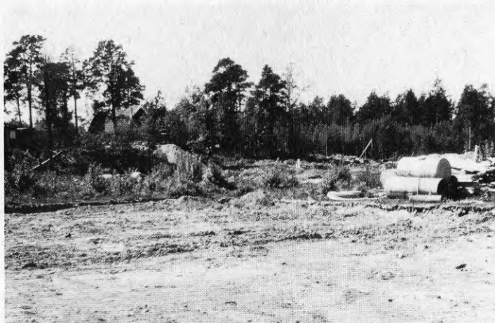
FIG. 25 Området för vändplanen innan arbetenas påbörjan.
