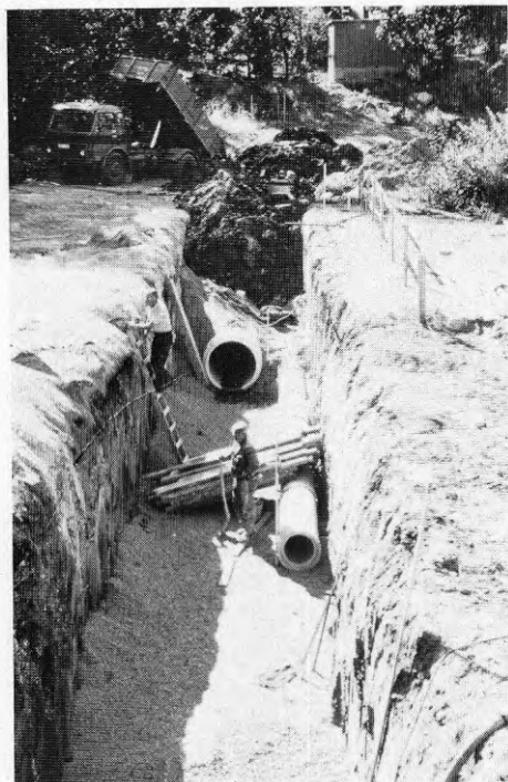
FIG. 33 Rörläggning i kalkpelarförstärkt schaktgrav.
