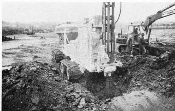
FIG. 37 Kalkpelarmaskin LPS 3 med skogsband
