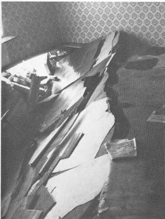
Foto AL54-55 Typiskt brott i mellanbjälklaget där överkantsarmeringen över hjärtväggen avslutades.
