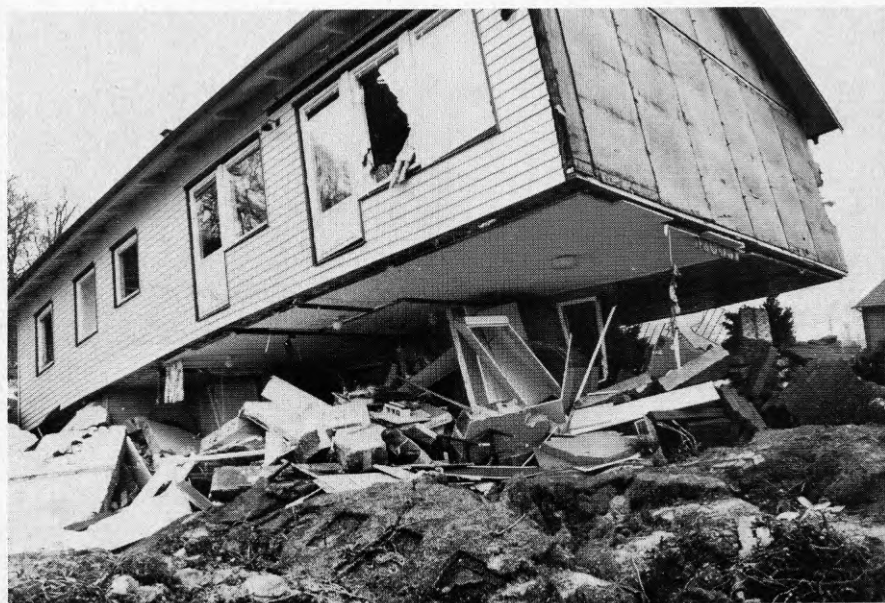
Foto SS6.2 Snarbergsstigen 6. Den överkragande delen från sydväst.
