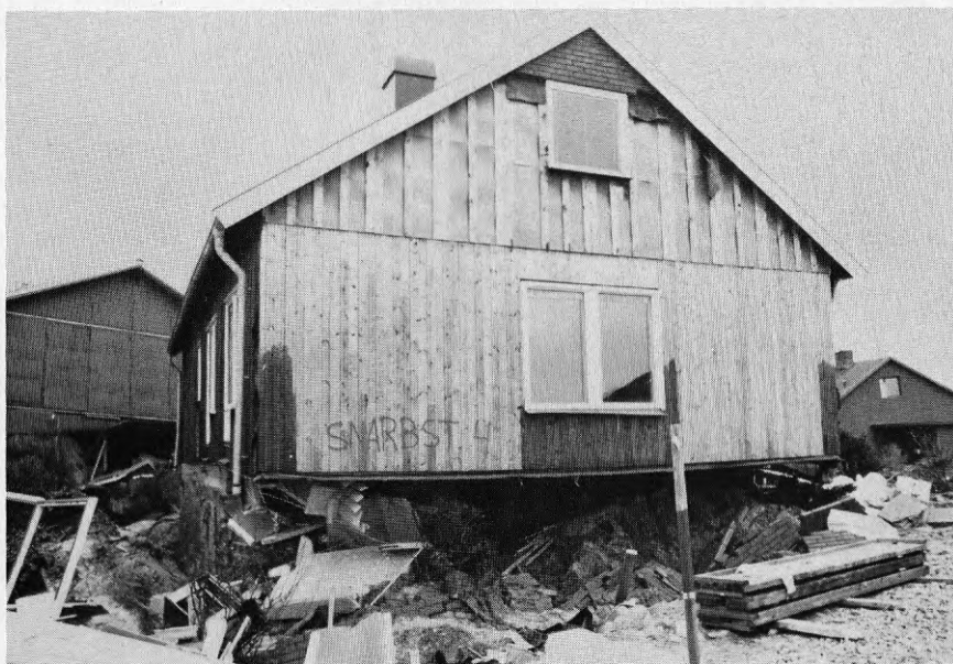
Foto SS4.2 Södra gaveln, Snarbergsstigen 4. Lägga märke till att överbyggnaden kragar ut fritt. I bakgrunden t.v. skymtar Snarbergsstigen 6.
