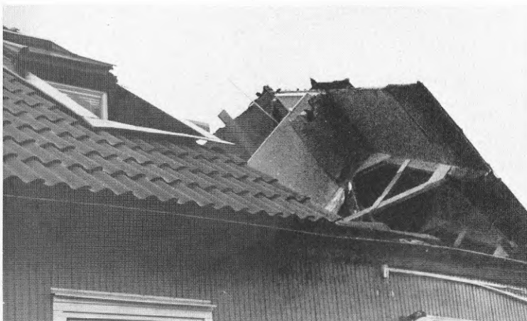
Foto TD9 Detalj av takkon- struktionen. Båda takskivorna var skarvade på samma takstol.
