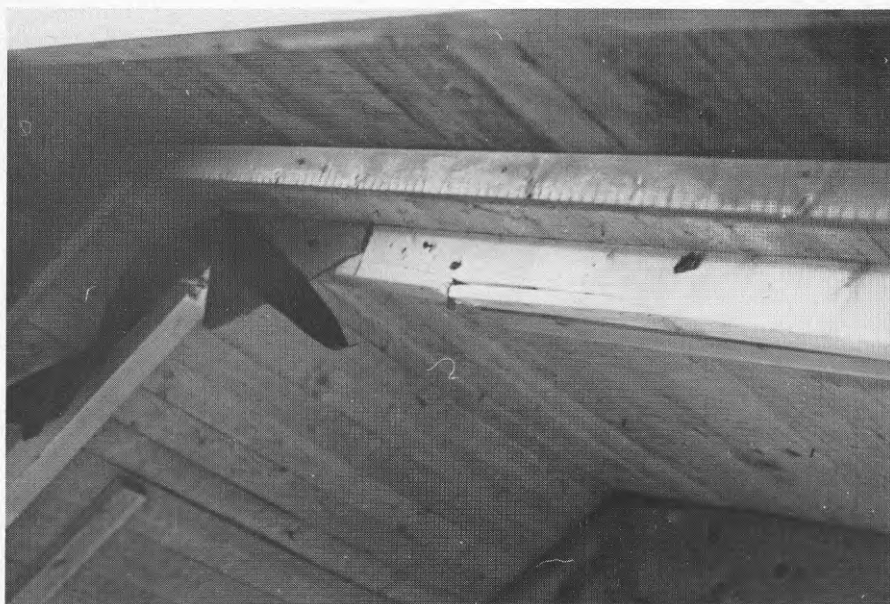
Foto SB1.3 Snarberget 1. Mitt på bilden syns ett spikbleck som hållit en väggregel i gavelkonstruktionen.
