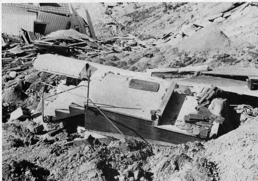
Foto SB10.4 Snarberget 10. Ungefär mitt i rasbranten låg den losslitna entrétrappan.
