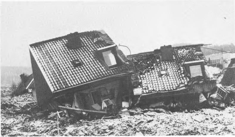
Foto AL17 Almhöjdsvägen 1 och 2 (till höger). Hus 1, som var ett gavelhus, har klarat sig bättre än hus 2.
