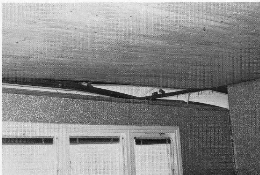
Foto SS5.2 Snarbergsstigen 5. Mellanväggens lyftning från insidan.
