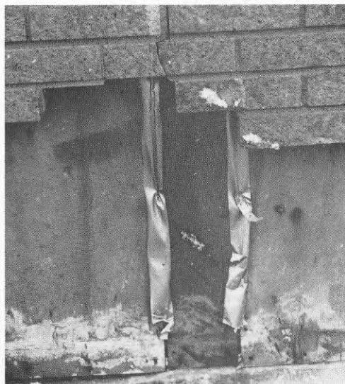
Foto AL36 Vindtätning av skivskarvar med tejpremsor.
