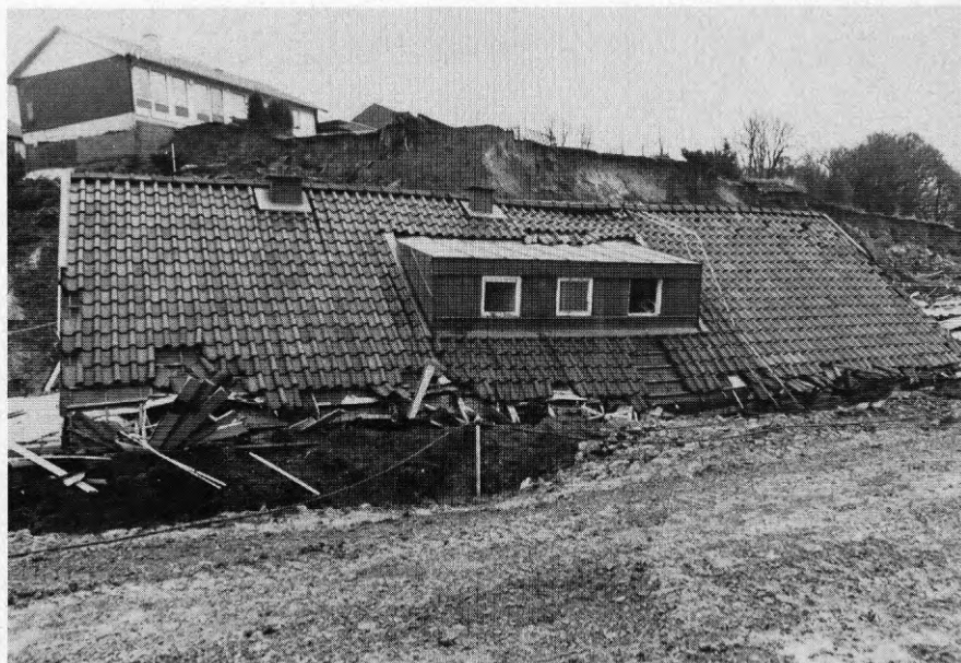
Foto SB10.1 Snarberget 10. Taket sett från söder.
