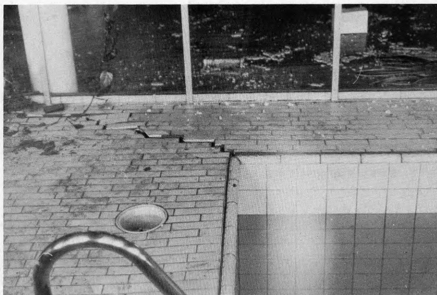
Foto SS7.3 Snarbergsstigen 7. Spricka i golvet intill bassängen som trots åkturen håller vatten.
