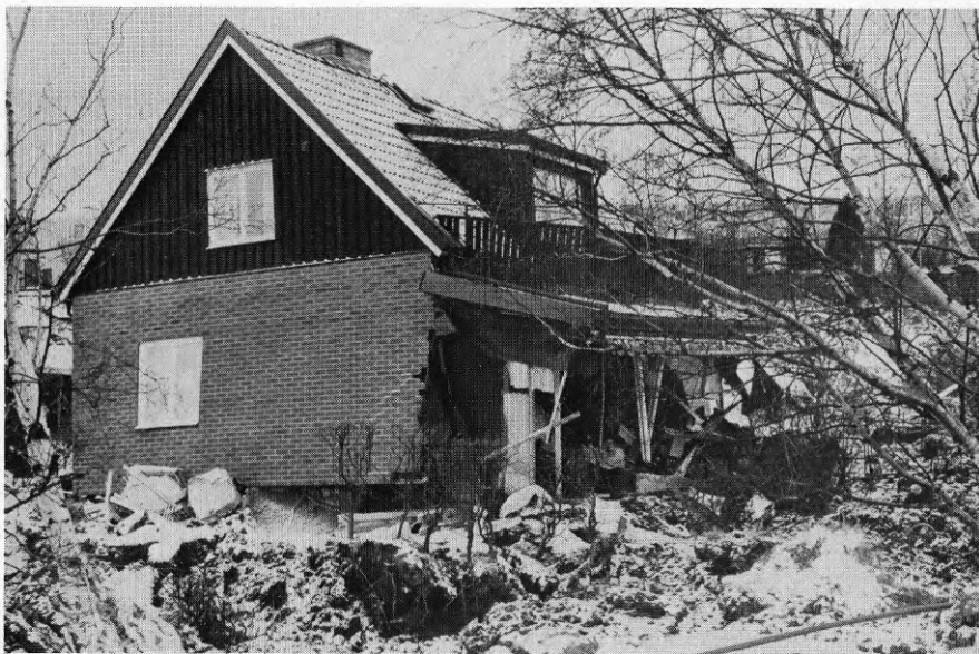
Foto Hlv1.2 Hedelundsvägen 1 med utbyggnad över garaget sett från nordost.
