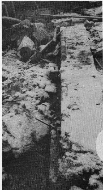
Foto AL52 "Stick" mellan grundplatta och källarväggar.
