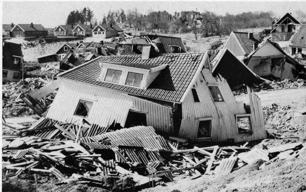
Foto SB2.2 Snarberget 2 från norr. Takets vriddeformation framgår tydligt.
