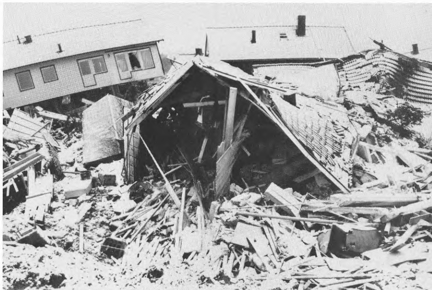
Foto SB5.1 Snarberget 5, nordvästra gaveln. I bakgrunden syns bl a Snarbergsstigen 6 (t.v.) och Snarbergsstigen 4 (t.h.).
