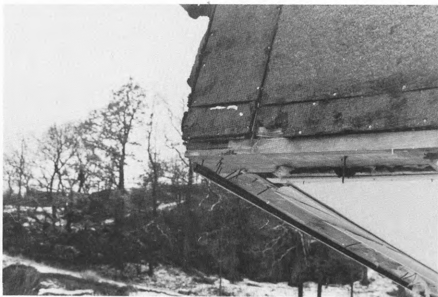
Foto SS6.4 Snarbergsstigen 6. Syllskarvning genom urhakning.
