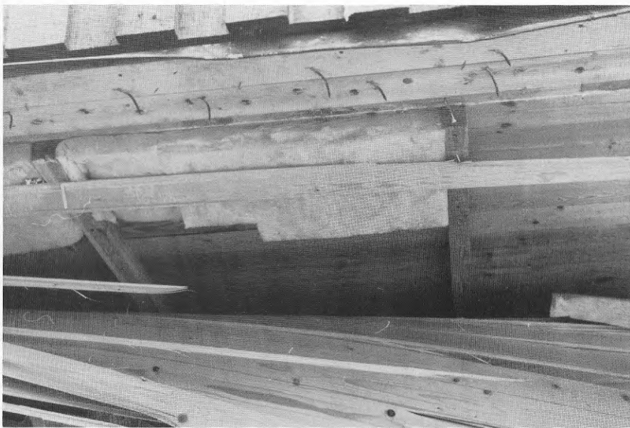
Foto SS4.5 Snarbergsstigen 4. Den fribärande delen av huset sedd underifrån.
