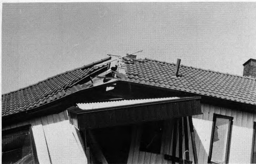
Foto SS2.5 Snarbergsstigen 2. Detalj av brottet i taket.
