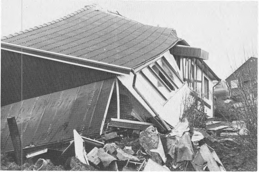
Foto SS2.2 Snarbergsstigen 2 sett från söder. Gavel- och långfasadskivorna har vikt sig utåt. I springan mellan fasaderna syns den hela övergolvsplanen i vardagsrummet.
