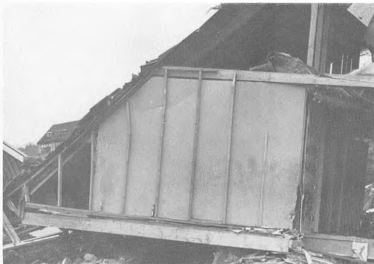
Foto AL24 Regelvägg på andra våningen. Lägg märke till att en av reg- larna knäckt.
