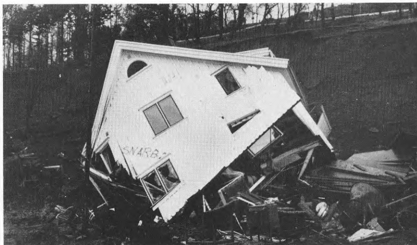
Foto SB2.1 Snarberget 2 sett från sydost.
