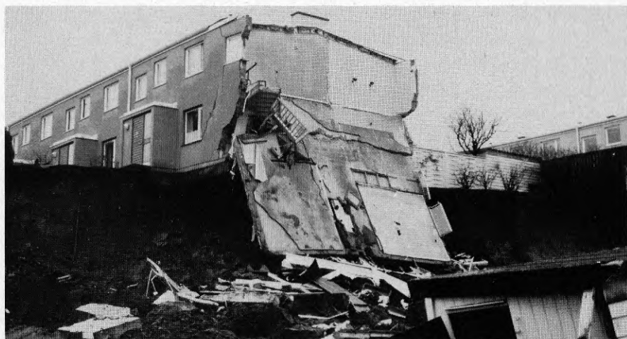
Foto TV8 Tångenvägen 5 M. Översikt. Lägga märke till den fritt ut- kragande grund- plattan.
