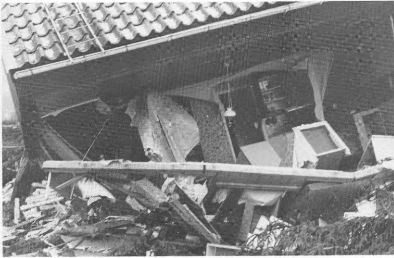
Foto AL18 Almhöjdsvägen 1. Mitt på bilden ligger köksytter- väggen. Hammar- bandet var tred- delat och skar- vat med en liten skarvbräda.
