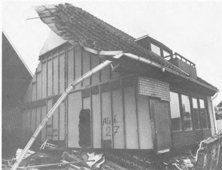
Foto AL23 Almhöjdsvägen 27. Regelsystem i lägenhetsskiljande vägg. Regelsyste- men (utan skivbe- klädnad) tillver- kades som ele- ment och lyftes på plats.
