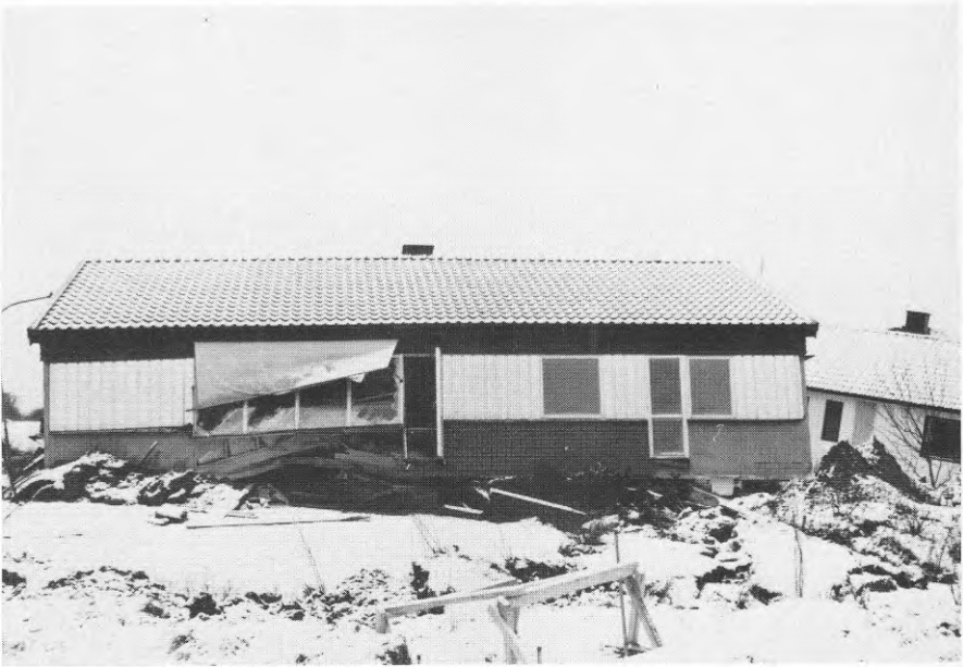
Foto SS3.1 Snarbergsstigen 3, östra långsidan. Lagg märke till överkragningen till höger.
