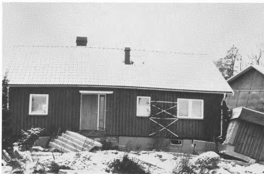
Foto SS4.1 Östra fasaden av Snarbergsstigen 4
