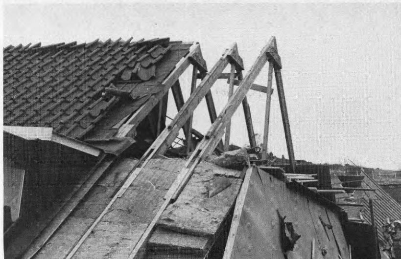
Foto A126-27 Takkonstruk- tionens upp- byggnad.
