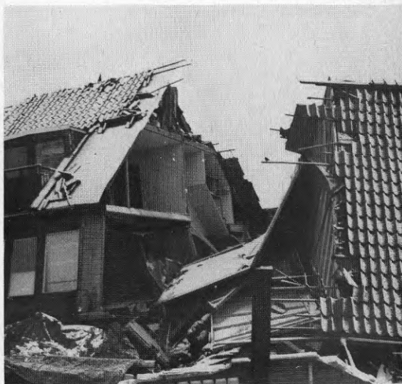
Foto AL21-22 Husen 34 och 35 har sjunkit samman och glidit en bit från hus 36. I springan mellan husen syns tydligt konstruktionen hos den lägenhetsskiljande väggen.
