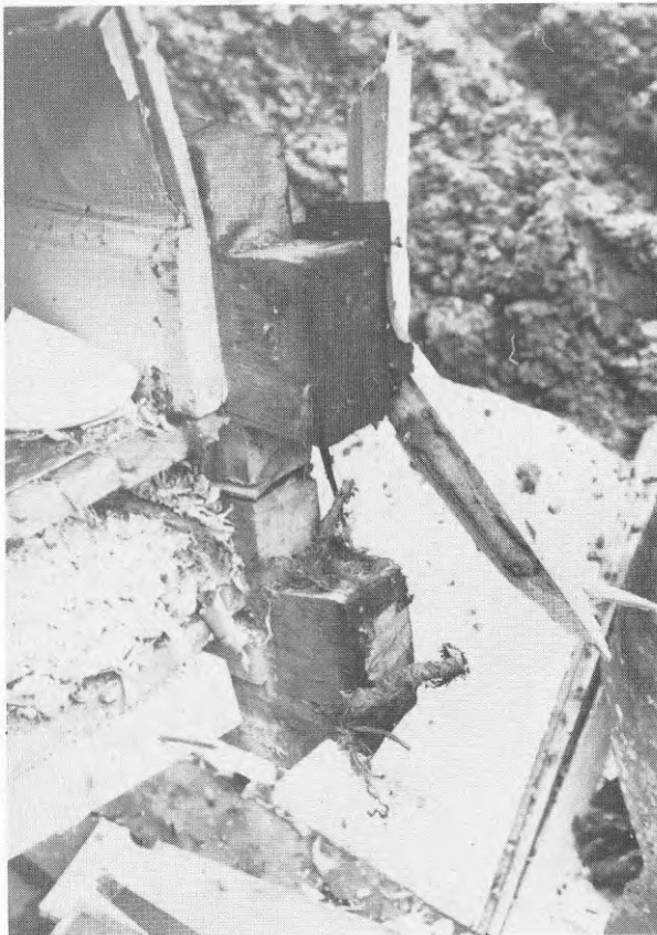
Foto SB2.4 Snarberget 2. Hopfästning av väggarna med sink- ning i hörnen.
