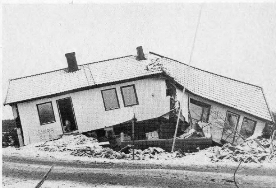
Foto SS2.1 Snarbergsstigen 2 sett från nordväst. Den högra delen är svårt sönderbruten i både källare och våningsplan. I den vänstra delen har våningsplanet skadats lindrigt.
