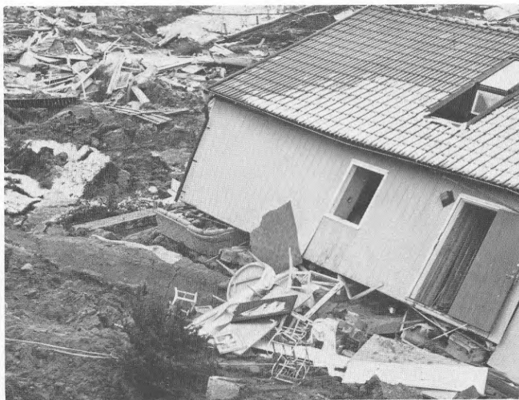
Foto TD14 Tångelund 2A Huset har tippat åt höger och lossat från bjälklaget. Till vänster står en soffa kvar i vardagsrummet.
