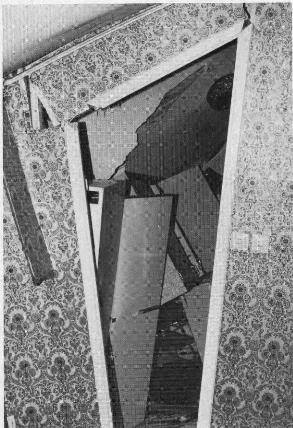
Foto SS2.4 Snarbergsstigen 2. Bild in mot köket från entrén. Brytstället tvärs byggnaden går ungefär vid högra dörr- karmen.
