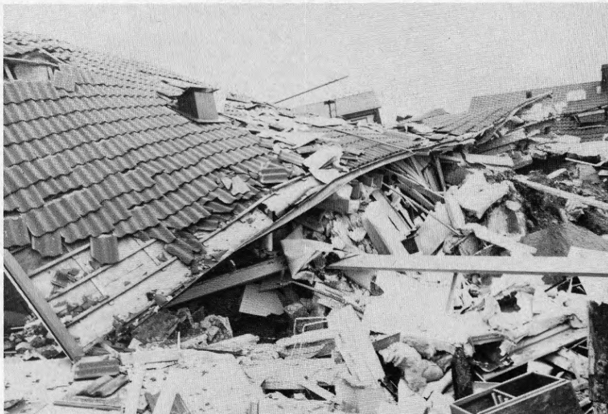
Foto SB5.3 Snarberget 5. Rester av väggar och bjälklag, sydvästra långsidan.
