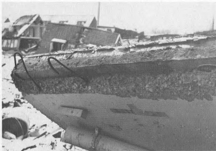
Foto AL49-50 (nedan) Uppsprickning i källarväggar vid gjutfogar. Ingen fogarmering fanns.
