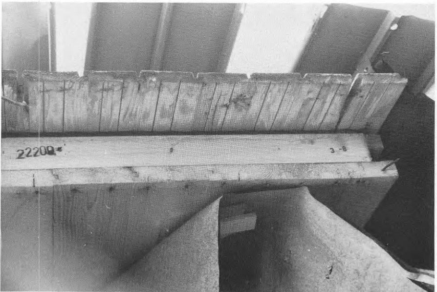
Foto SS2.3 Snarbergsstigen 2. Fasadvägelementens utformning.
