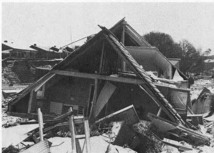
Foto A128 Almhöjdsvägen 1 och 2 (närmast). Husen har åkt tillsammans men delat sig i lägen- hetsskiljande vägg.
