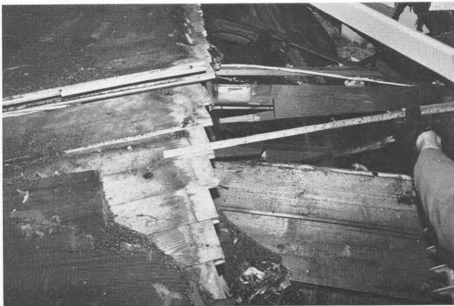
Foto SB2.5 Snarberget 2. Skjuvdeformation hos mellanbjälk- laget vid den södra gaveln.
