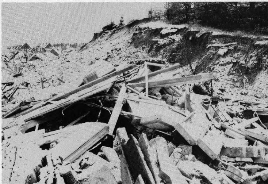
Foto SS8.1 Rester av Snarbergsstigen 8 från öster. Till vänster ligger en övergolvs-kiva med regler som hänger samman trots bortfallet av betongelementen.
