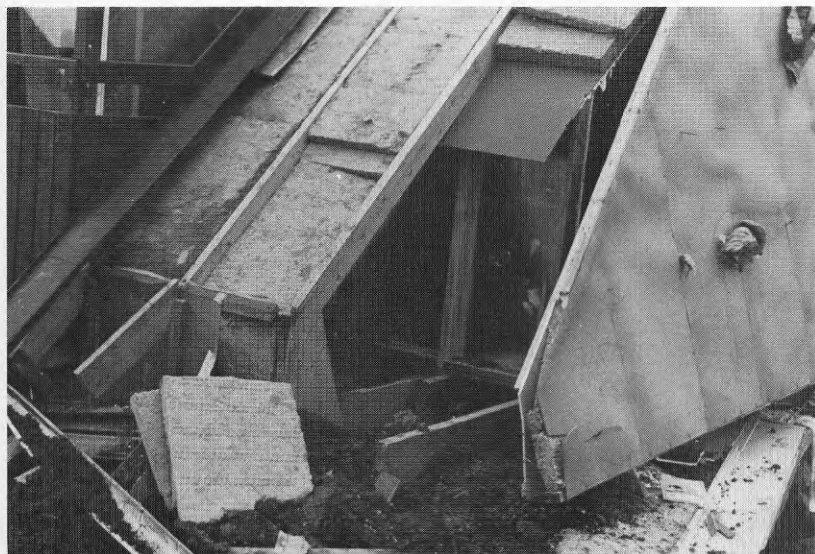
Foto A126-27 Takkonstruk- tionens upp- byggnad.
