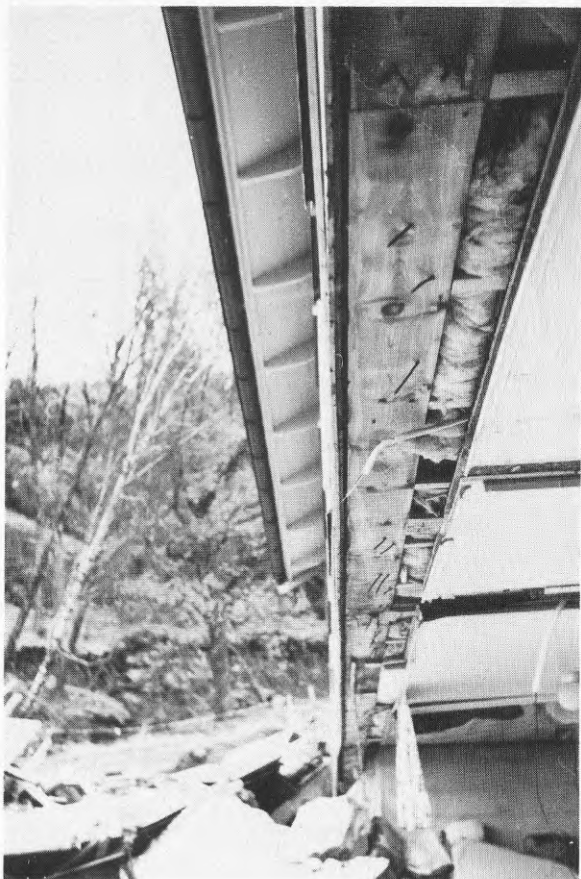
Foto SS6.3 Snarbergsstigen 6. Spikning av syllen ner i grund- muren.
