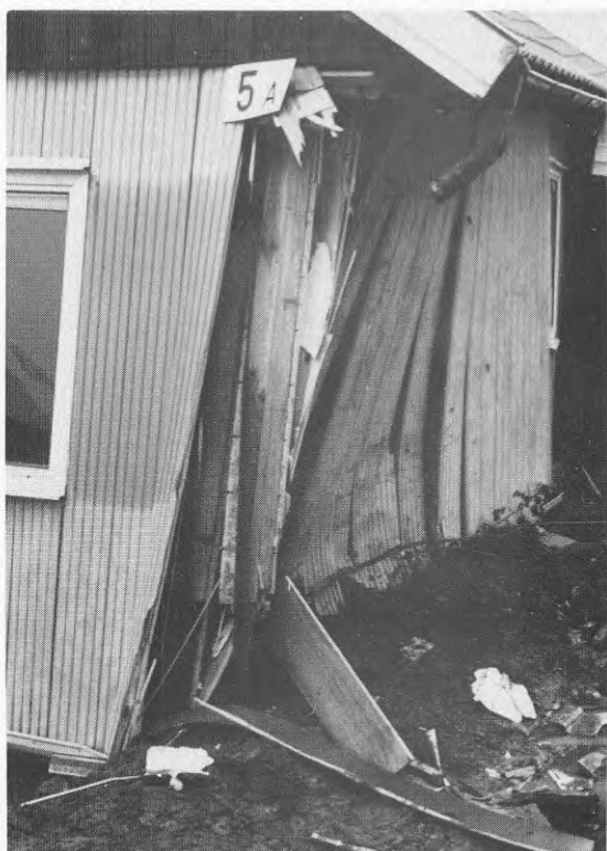
Foto TD33-36 Delningar mellan ytterväggselementen. På den övre högra bilden har väggen vikts in i huset.
