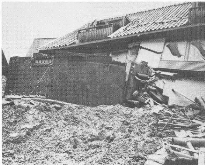
Foto AL41 Almhöjdsvägen 37 och 38. Bilden visar hur husen har vält baklänges. Källaren har fortsatt längre fram.
