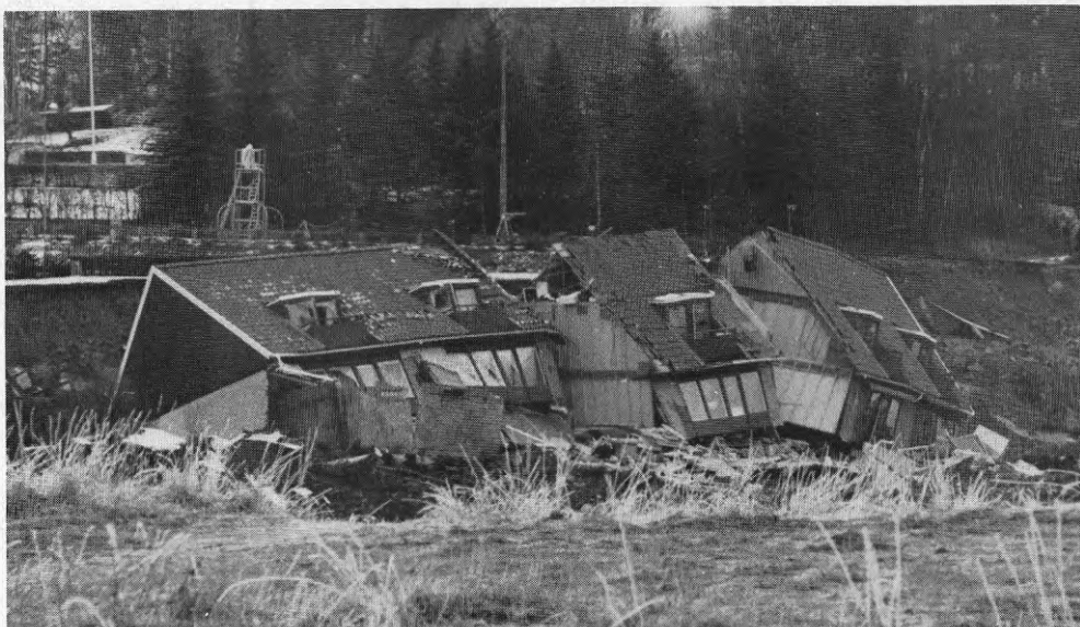
Foto AL20 Almhöjdsvägen 34 - 38 (38 till vänster) två dagar efter skredet. Överbyggnaden ser fortfarande relativt intakt ut hos husen 34 och 35.
