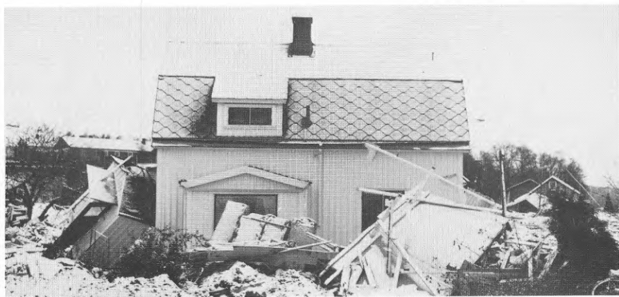
Foto TK1-2 Tuve Kyrkväg från nordväst (överst) och från söder (underst). Entrédelen på övre bilden vältes bort efter raset.
