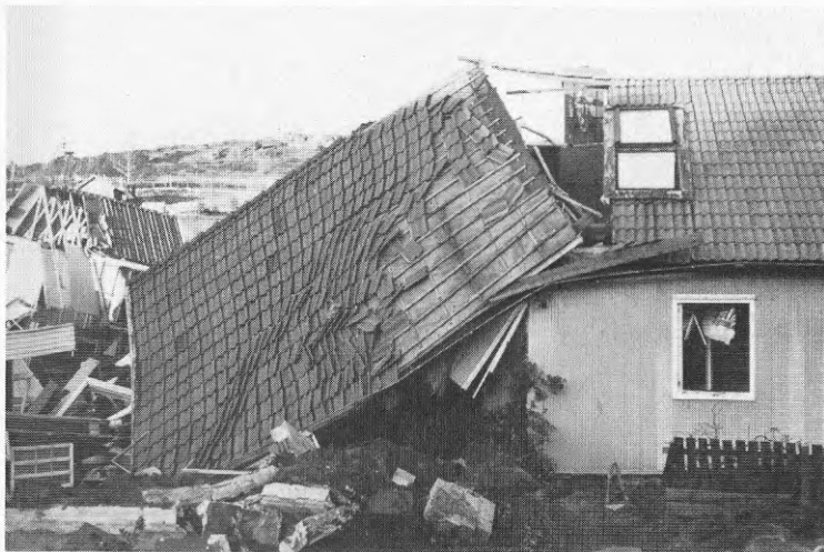
Foto TD8 (13/1-78) Tångelund 3C, södra längsidan, efter det att överhänget rasat.
