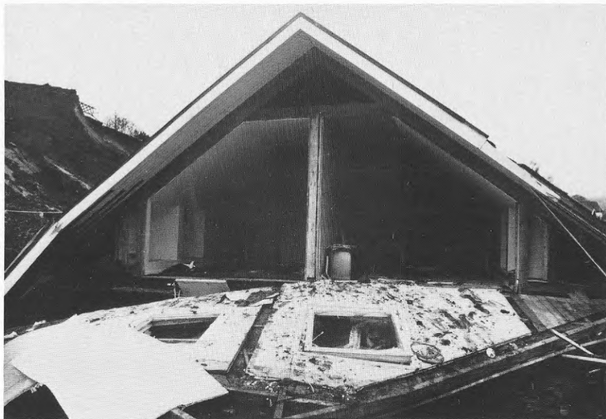
Foto SB10.2 Snarberget 10. Västra gavelspetsen med utvält gavelskiva.
