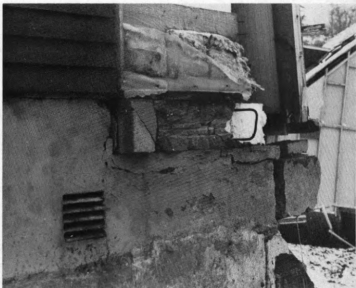
Foto AL34 Armering och isole- ring i kantbalken.
