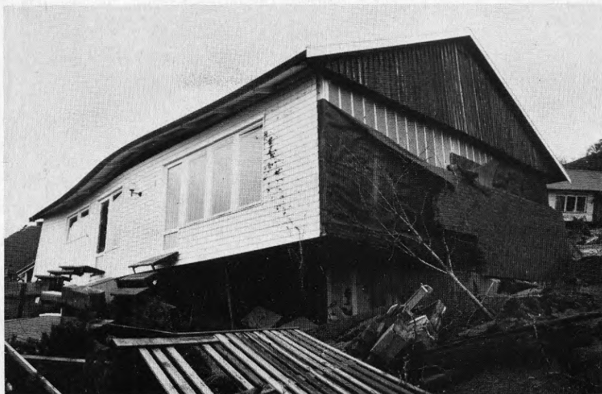
Foto SS5.1 Snarbergsstigen 5. Överhäng över gillestuga i närmaste hörnet. Vid takfot syns en springa p g a mellanväggens lyftning.
