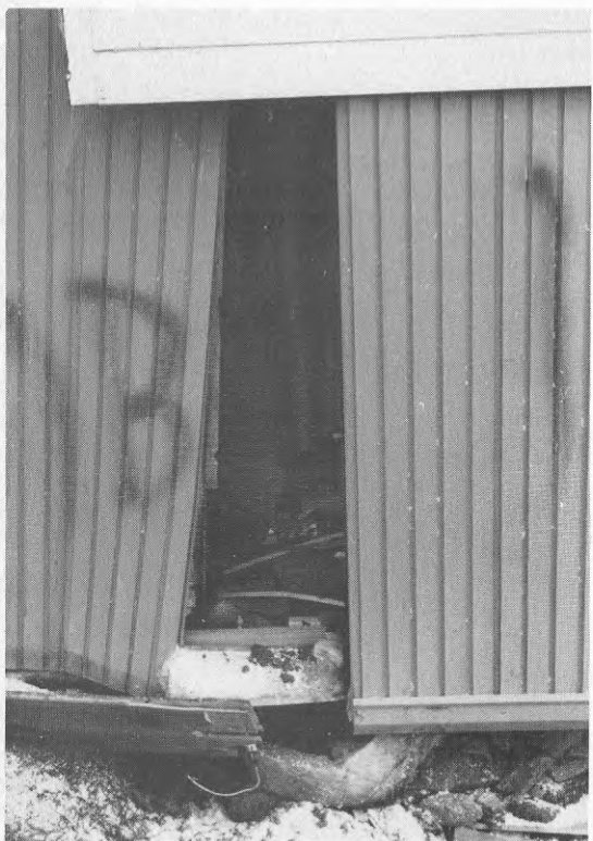
Foto TD33-36 Delningar mellan ytterväggselementen. På den övre högra bilden har väggen vikts in i huset.
