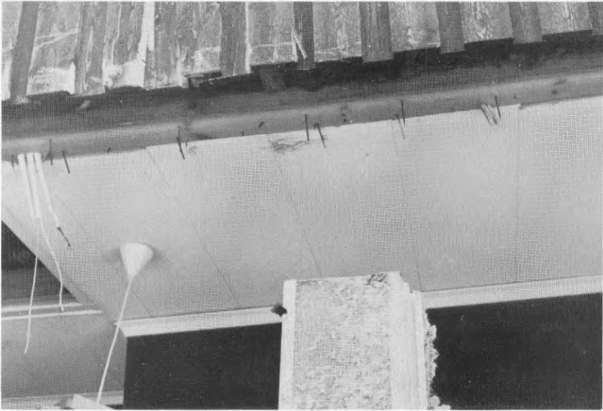
Foto SS5.3 Snarbergsstigen 5. Infästning av hammarband i väggelement.
