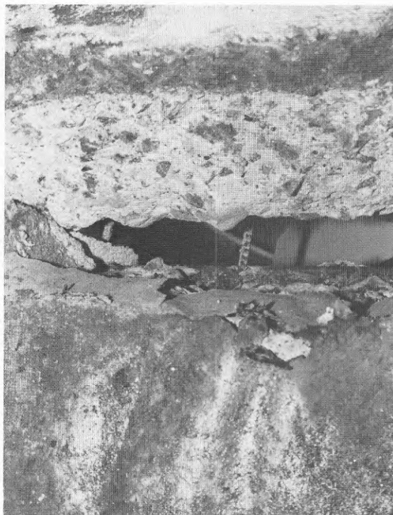
Foto AL54-55 Typiskt brott i mellanbjälklaget där överkantsarmeringen över hjärtväggen avslutades.
