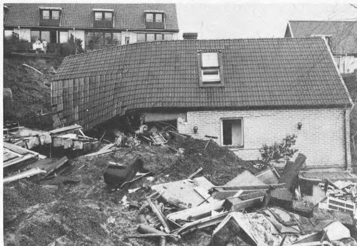
Foto TD28 Tångelund 7E Delar av vardags- rummets golv och väggar ligger till vänster. I för- grunden ligger delar från Tångelund 7D.
