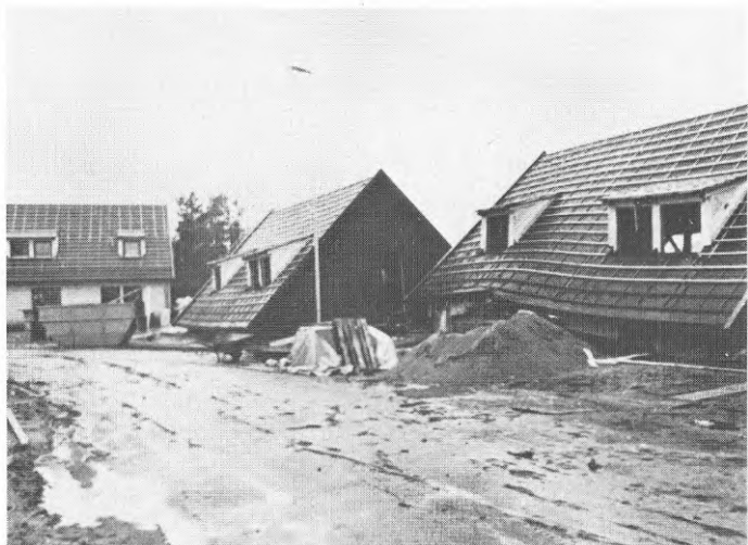
Bild 7.3.2 visar två av de tre vid skadetillfället raserade husen. (Det tredje huset syns till höger på bild 7.3.3.)
