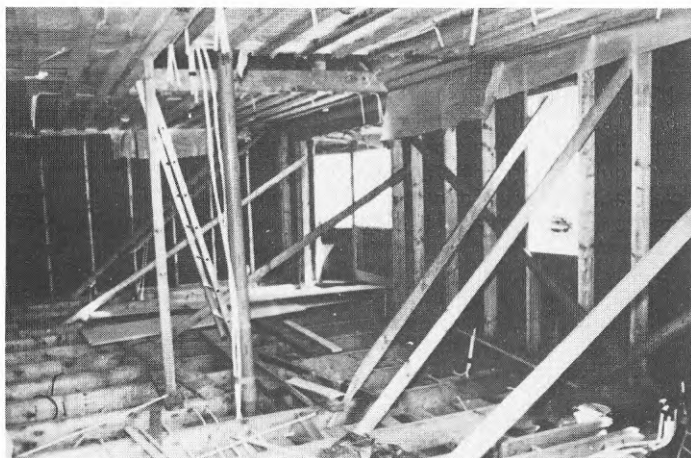
Bild 7.2.13 visar det inre av samma hus mot läsidan.
