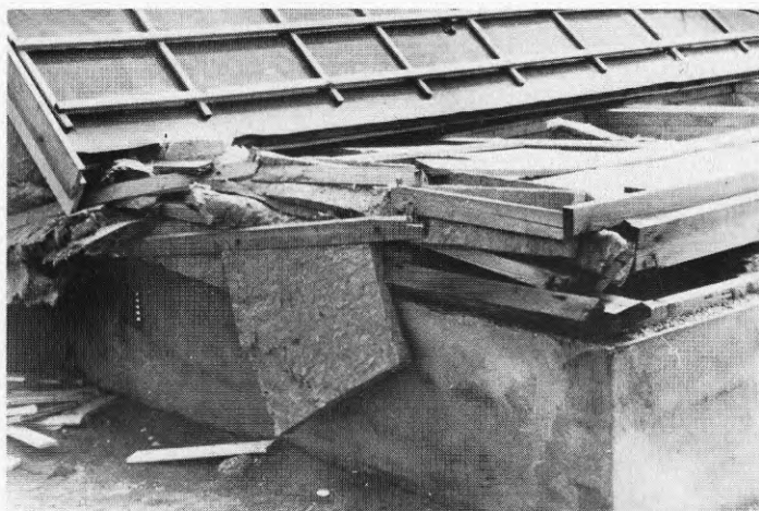
Bild 7.2.7 visar lovartsidans omkullslagna vägg vid det nordvästra hörnet med rester av den hopknycklade gavelväggen.
