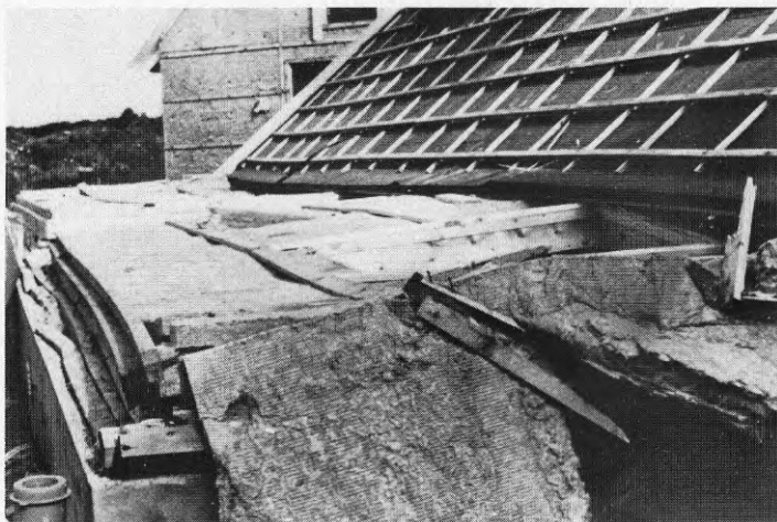
Bild 7.2.6 visar den västra nedbrutna väggen på lovartsidan. Man ser, liksom på föregående bilder att väggen var försedd med utanpå regelverket monterade fasadskivor av mineralull. Vidare framgår att fönstren ej var insatta.
