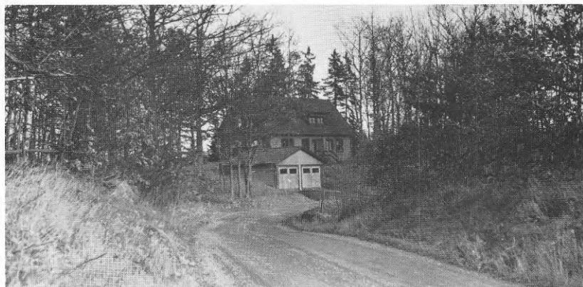
Byggnaden har fått ett ganska dominerande läge, men är ändå fint inpassat i sin skogsdunge.
