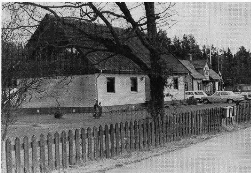
Även individuellt ritade hus får ofta låna många av typ- husens just då gångbara drag. Här avspeglar sig idealen från mitten av 1970-talet i fasadmateriäl, fönstertyper och indragen gavelbalkong.
