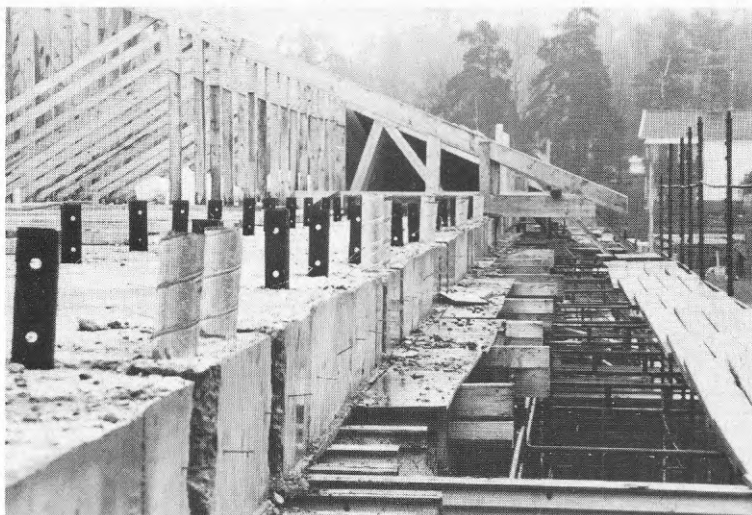
Bild 10. Husdel C, anslutning av kanaler för värme- lagring
