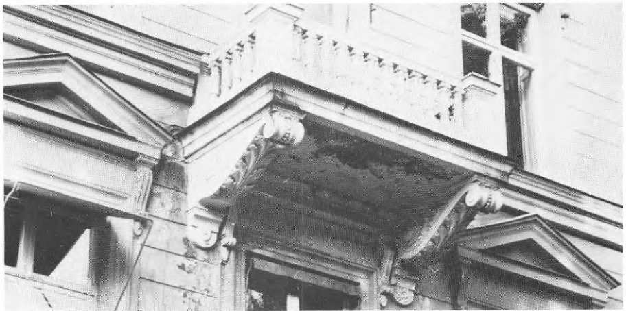
Balkong på konsoler och tympanonfält ovanför fönstren.
