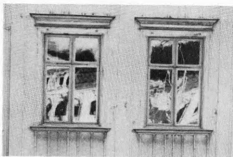
Ett fönster kan delas upp i sina beståndsdelar - glasskivor, karmar, bågar och beslag. Fönstret som avgränsad helhet ingår i ett större system - huset.
