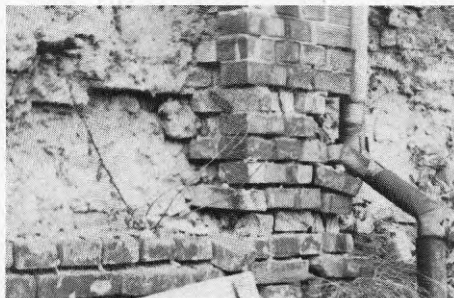
Frostskadad murstensvägg.
