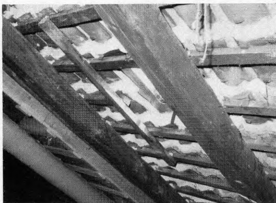
BILD 3. Tegeltaket sett från vinden.
