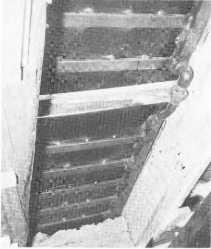
BILD 4. Solfångarna innan isoleringen monterades.
