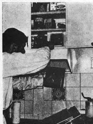
3. Kanalen rensas ur med sudd genom rensluckan på bikanalen. Imstötet samlas upp i särskilt kärl.
