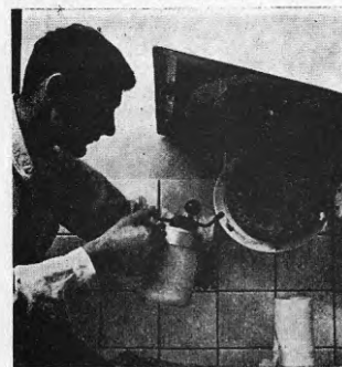
4. Fläkthjulet och fläkthuset sprayas med fettlösningsmedel och avtorkas.
