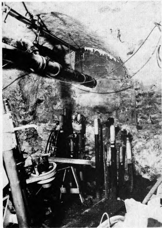
Pålgrupp före kapning
