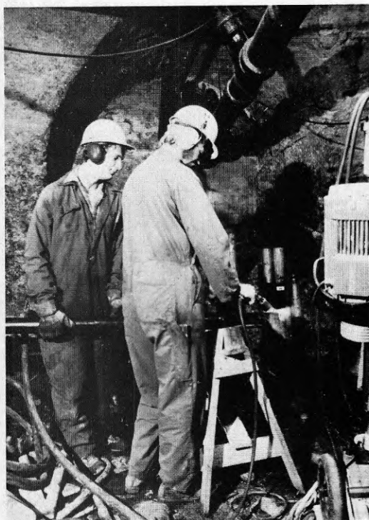
Uppvärmning av plastskikt för skarvning av påle
