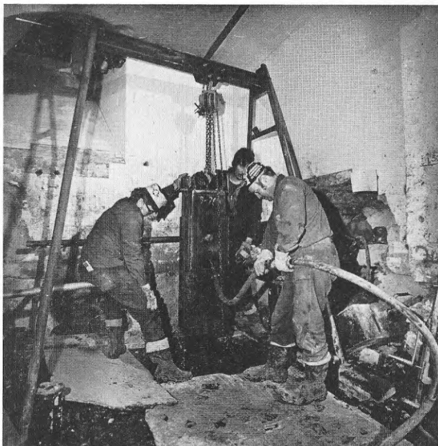
Pålslagning med tryckluftshejare typ Atlas Copco PH 180 K.
