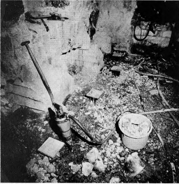
Grovplanering före armering och gjutning av betongplattan.
