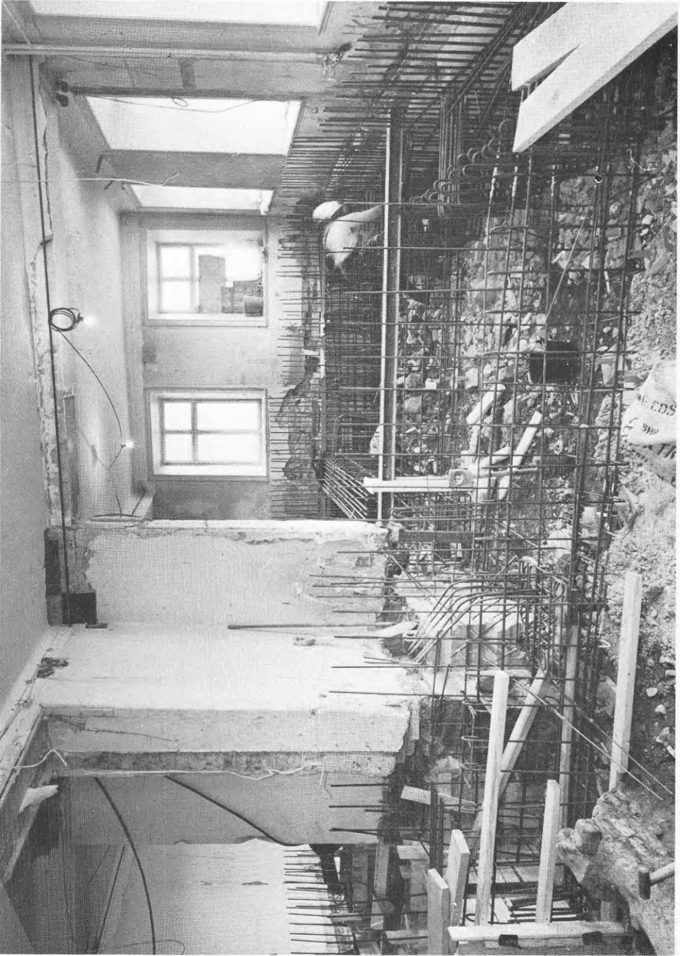
Armering och formsättning av balksystem.
