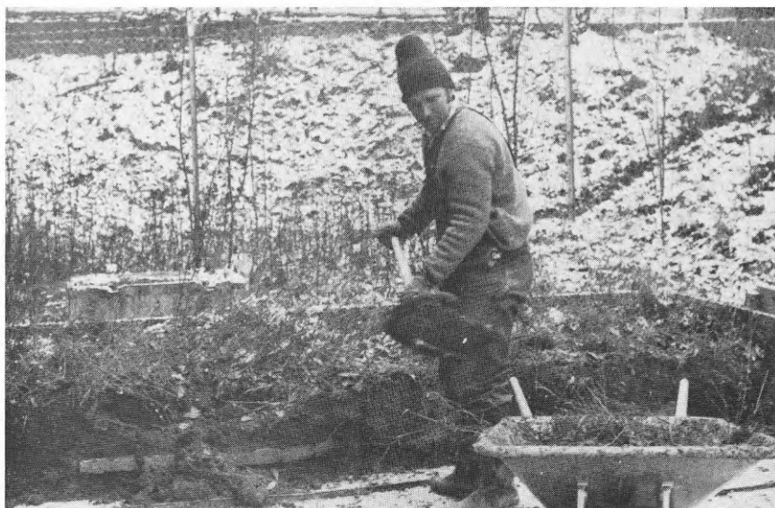
Fig 21 Uppgrävning av terrassbjälklag 2
