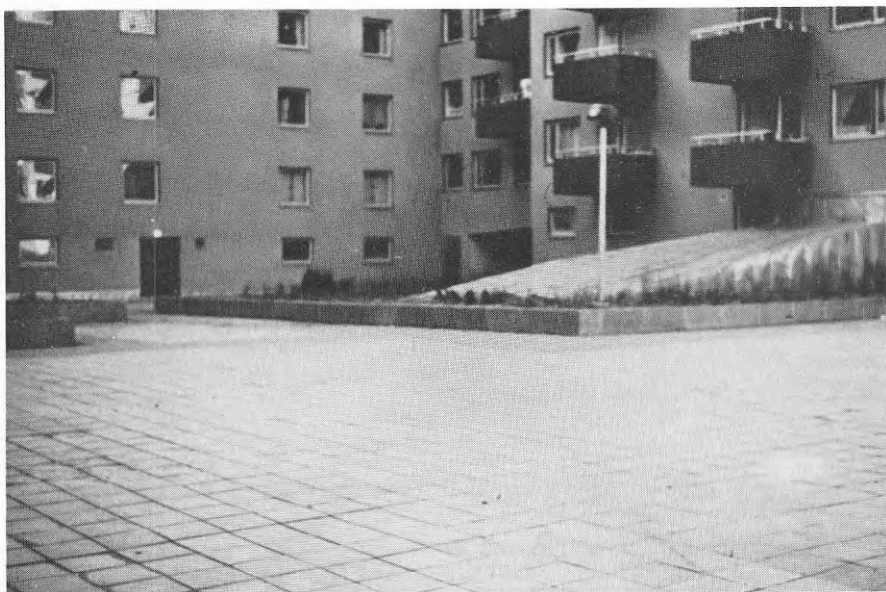
Fig. 2 Färdigställt terrassbjälklag med överbyggnad. Projekt Stockholm, Kv. Bunge
