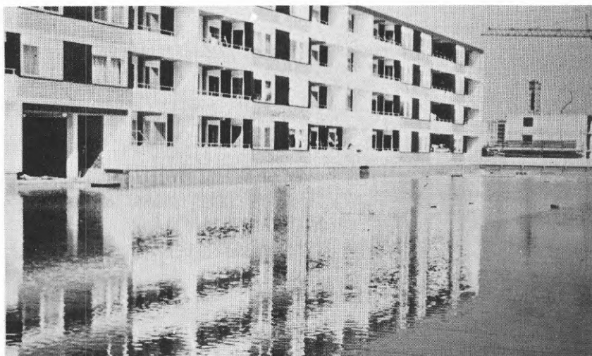
Fig. 7 Kontroll av rostfritt tätskikt genom vattentryckprovning Projekt Huddinge, Wårby gård
