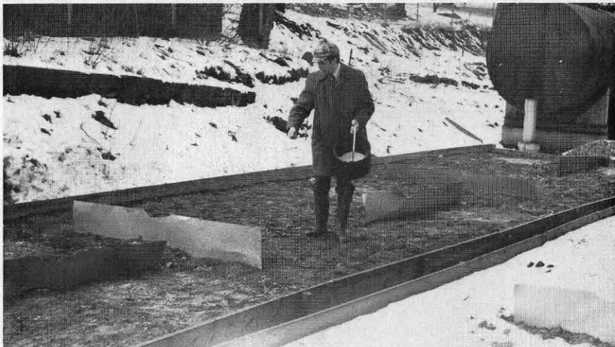
Fig 18 Saltning av terrassbjälklag 2
