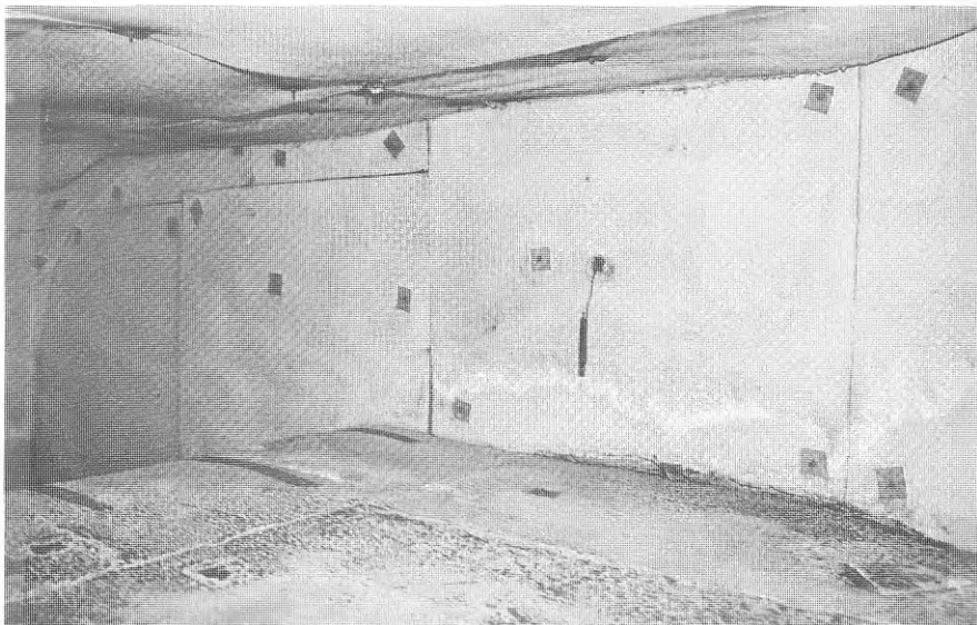
Fig 2.1.2. Intagskanal med invändig asbestisolering.
