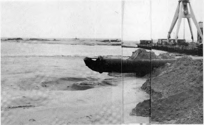
Figur 6. Krater vid inspolningspunkt för rörledning.
