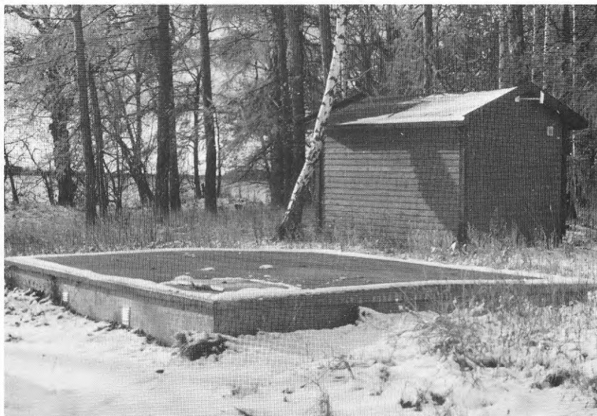
Figur 5.4 Mätboden intill ventilbyggnaden vid Vätterns strand. På mätbodens gavel sitter utomhustemperaturgivaren.
