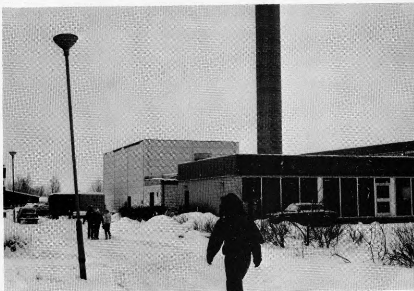
Figur 3.2 Platens panncentral med värmepumpsbyggnaden i bakgrunden.
