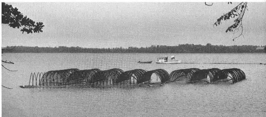
Figur 3.5 b Foto av spiralkollektorn före sänkning på den avsedda platsen.
