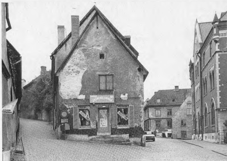
Figur 6.1 På medeltidshuset mot norr hittade man under putsen luckor och korsvirke . . .
