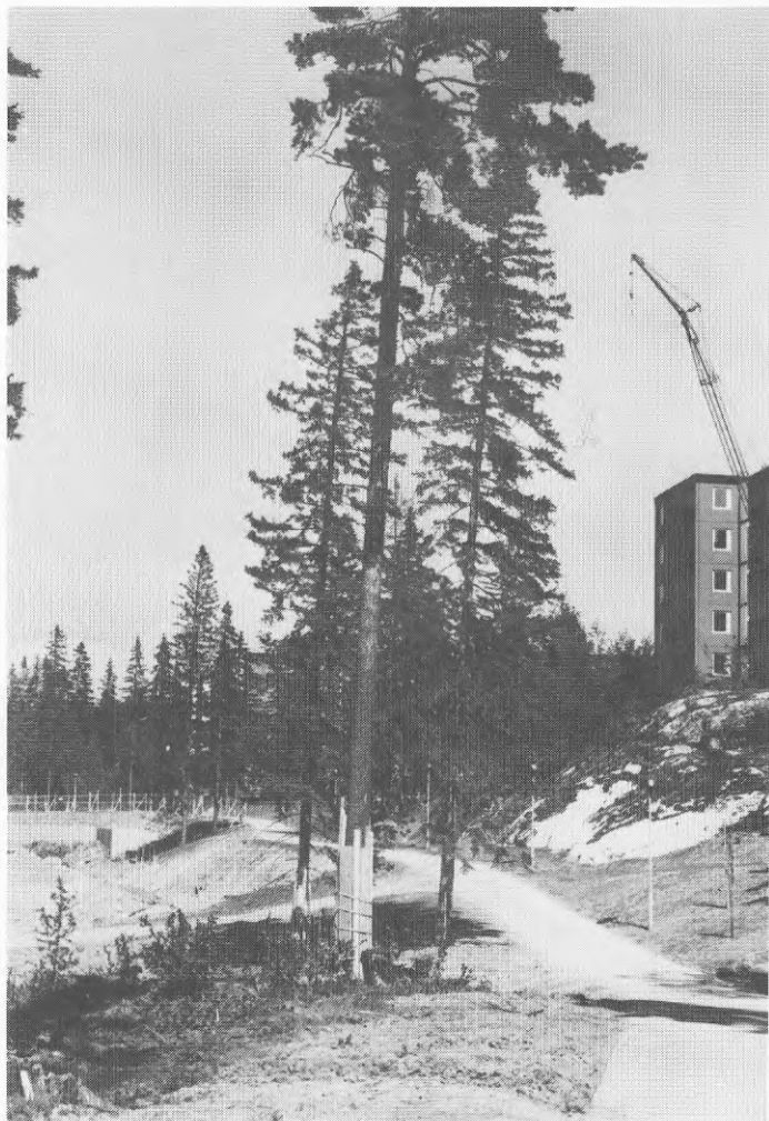
Figur 16. Mellan tallen och de två granarna har man schaktat jord och sprängt, varvid alla tre träden fått allvarliga rot-skador. Lägg också märke till de små slyplantorna på den orörda marken nedtill till vänster. Mellan slyplantorna och gångvägen har matjord förts på.
