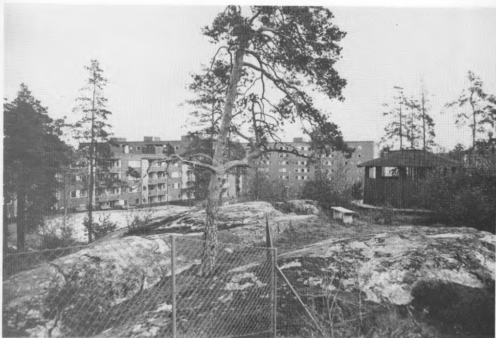
Figur 14. En bergklack inom bebyggelsen tre år efter byggstart, två år efter inflyttning.
