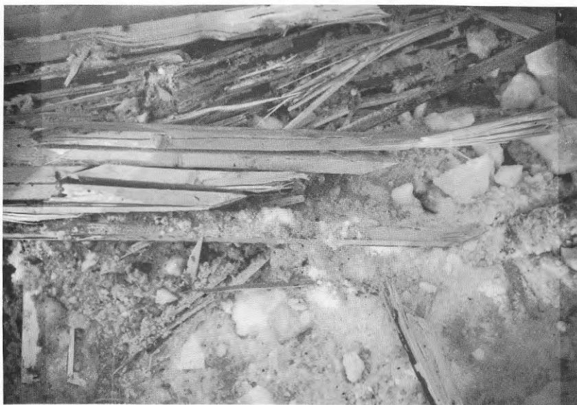
Figur 11.2. Lamellskarvarnas placering i underfläns vid balkens mittdel i förhållande till varandra.
