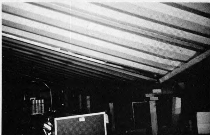
Fig 4. Brott i tak av profilerad plåt har karaktär av veckning över stöd och i fält. Med de stora nedböjningarna följer ett ändrat funktionssätt som oftast hindrar instörtning.
