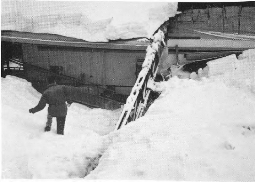
Figur 12.14. Nedstörtad fackverkstakstol.
