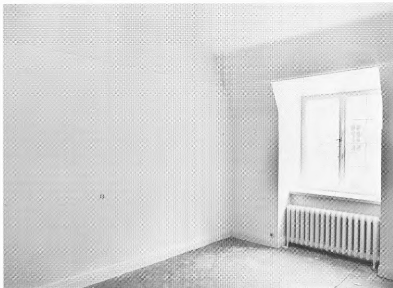
Fig. 4:5 Besiktning efter 18 månader. Ytorna fortfarande fina men viss gulning kan konstateras.
