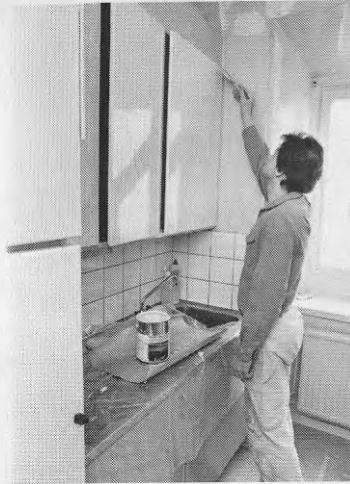
Fig.4:3 Målning av snickerier.
