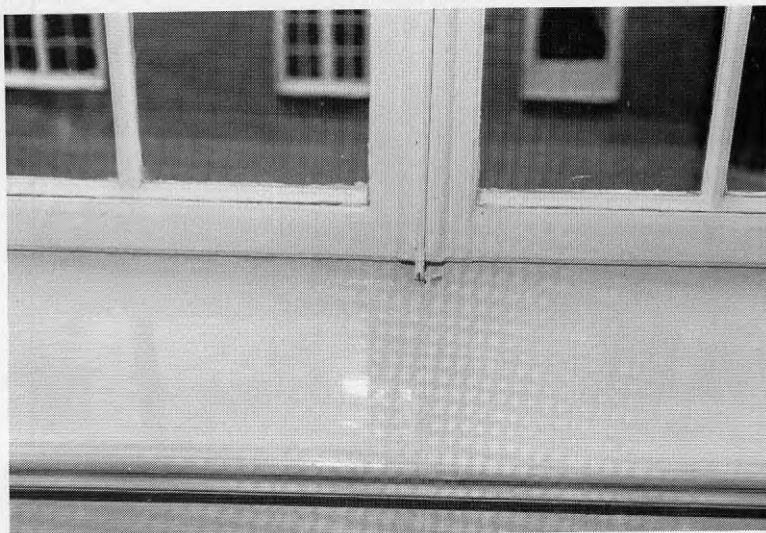
Fig. 4:6 Ytorna visade ej några tecken på krackelering.
