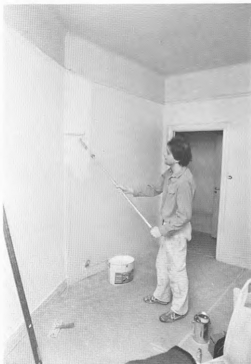
Fig. 4:2 Målning av väggar med dispersionsfärg.
