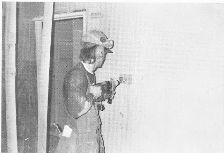
Fig 223. Gejderfäste monteras
