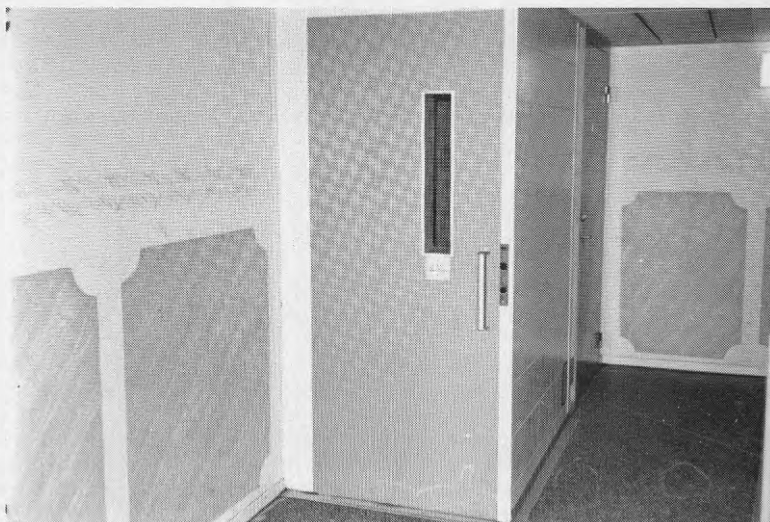
Fig 1:4 Resultatet färdiginstallerad hiss
