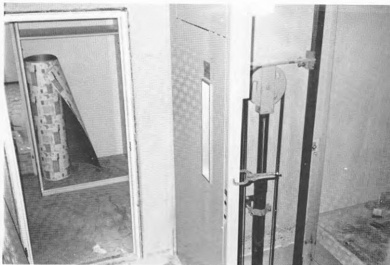
Fig 226. Front med hissdörr uppsatt
