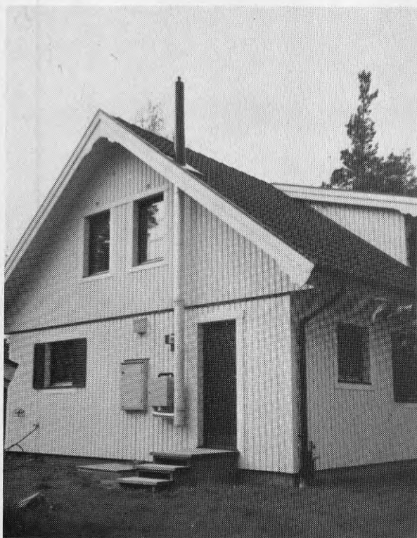
Figur 4.3 Peakheater med den nya skor- stenen på plats.
