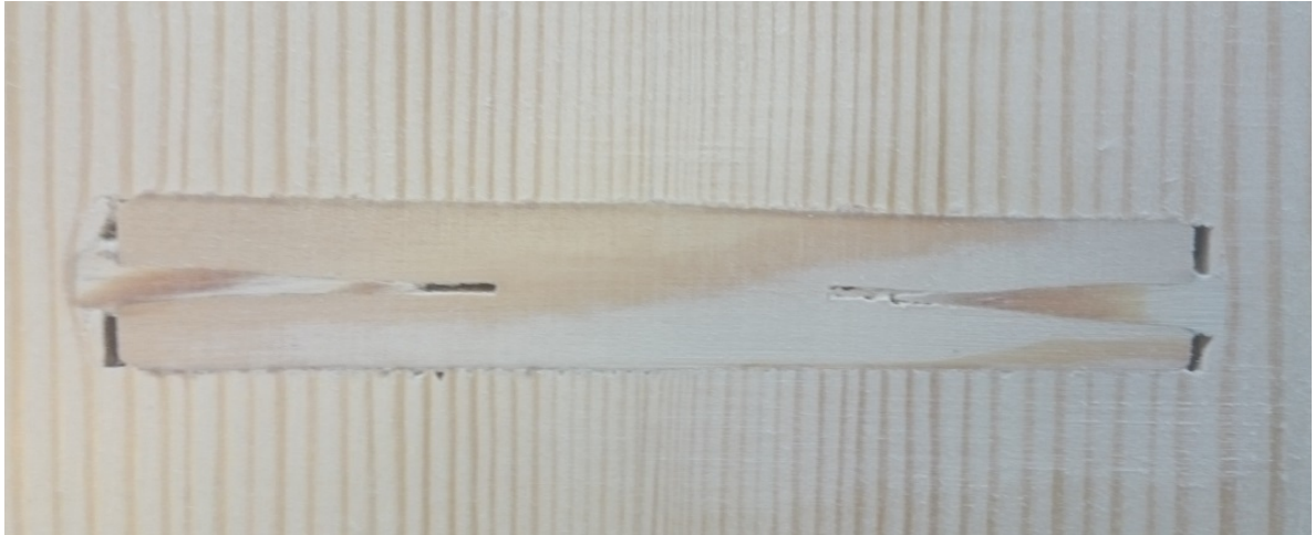
Figur 56. Infäst lötnagel i snitt.
