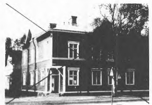
Byggnad nr 2: vid Storgatan Bostadshus med butik. Byggnadslov 1908 för byggmästare O A Johanson. Ritning saknas. Kärnan utgörs av ett timmerhus som flyttats från ytterhis- ke. 2 vån, fronten mot gatan. Fasader- na. Inga utskjutningar på gatusider- na. Stensöckel, trästomme (helt eller delvis av timmer). Liggande fas- spontpanel, blå med vita snickeride- taljer. Utskjutande sadeltak med syn- liga sparränder. Täckt med plåt. Liten trädgård med enstaka stora träd. Klass II
