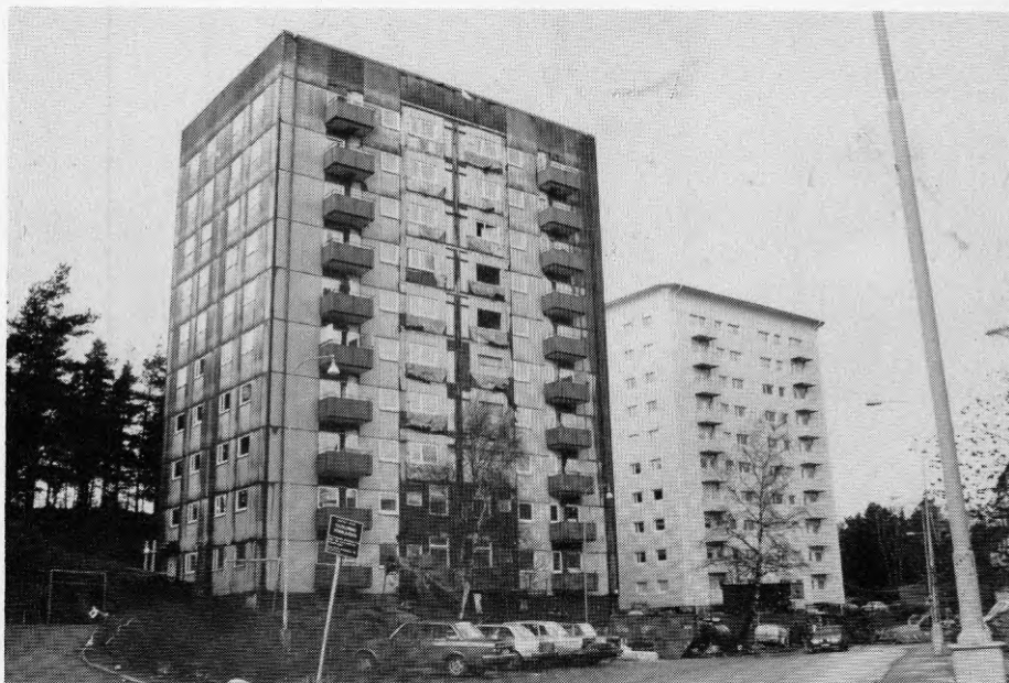
Höghus under ombyggnad
