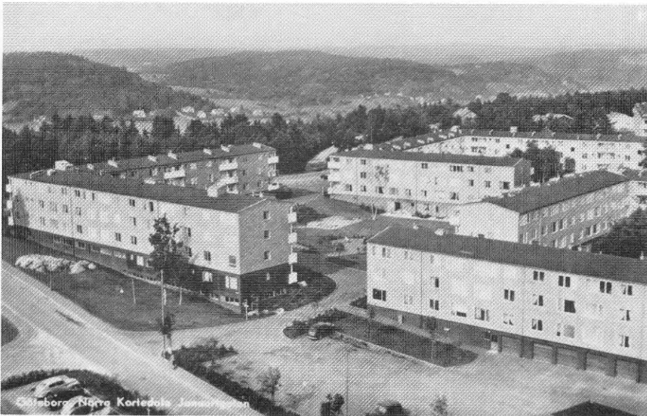
Ett av Kortedals grannskap som domineras av låghusbebyggelse, Januarigatan.
