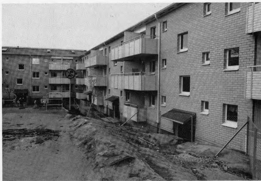
Decemborgsgatan före och efter ombyggnad.
