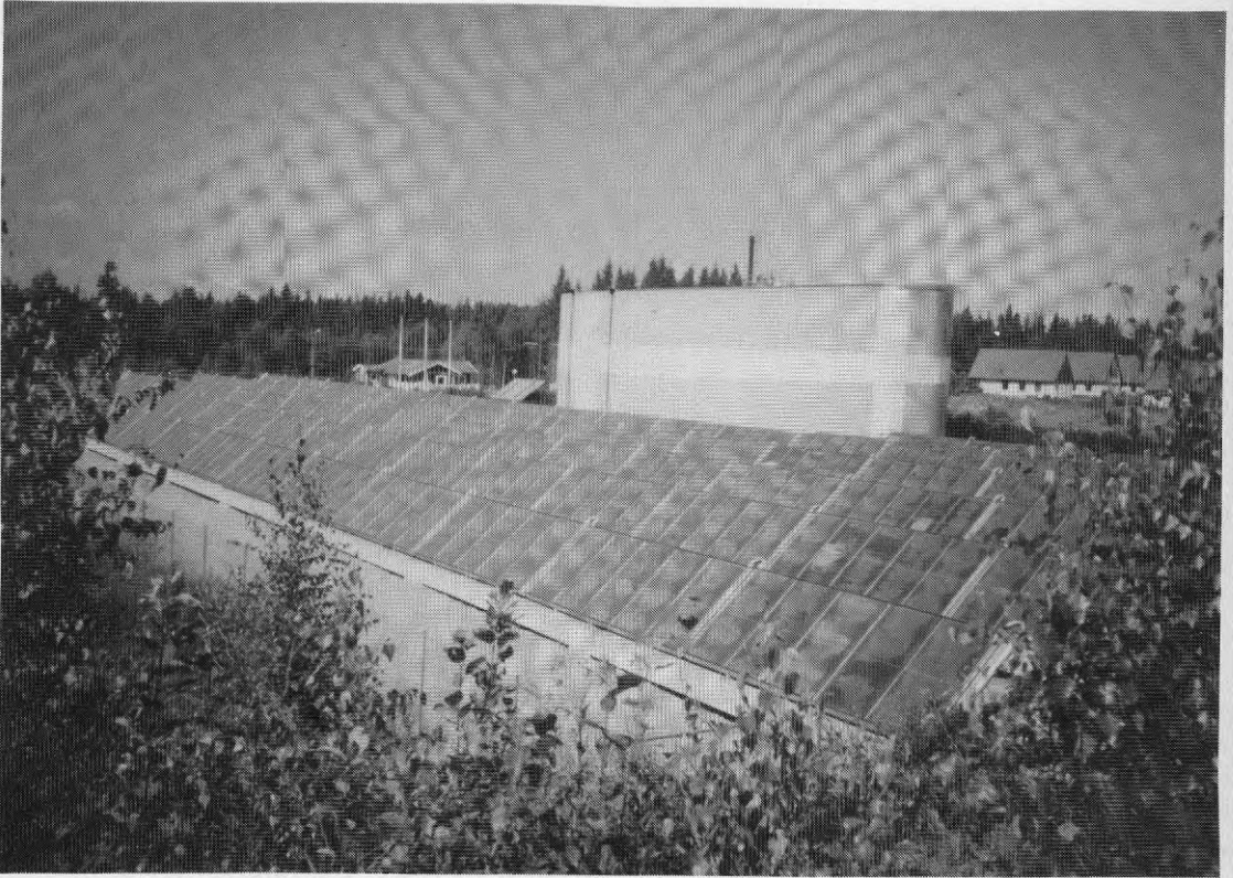
Bild 2 Ingelstadanläggningen (Ib, 1984-87) med plana solfångare från Scandinavian Solar (numera TeknoTerm).
