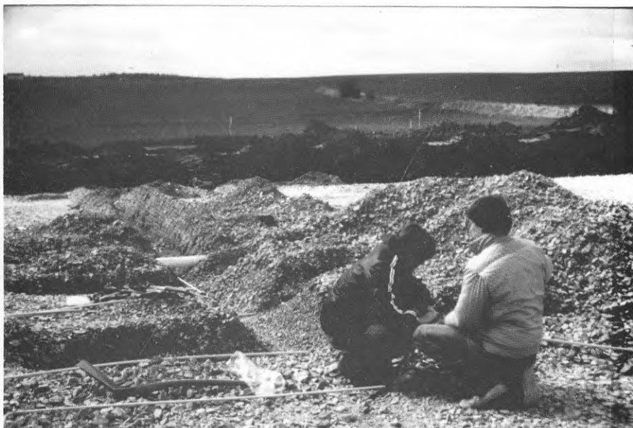
Figur 4:14 Utplacering av mätstationer för temperaturmätning efter uppgrävning av makadambärlagret.
