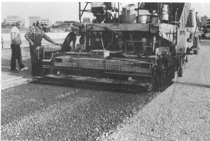
Figur 4:10 Justering av makadambärlager med asfaltutläggare.
