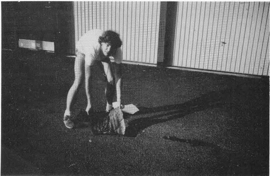
Figur 7.1:11 Galler till rännstensbrunn nedsatt i enhetsöverbyggnad vid igensatt beläggning i en lågpunkt inom området Glasberget, Göteborg.
