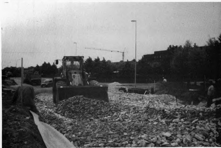
Figur 5:9 Makadam till bärlager förs ut med traktor på Ole Römers väg.
