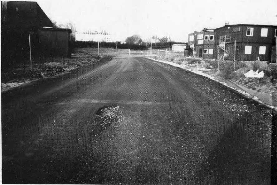
Figur 7.6:4 Potthål i sektion 380 i Ole Römers väg efter lappning och cirka ett års användande.
