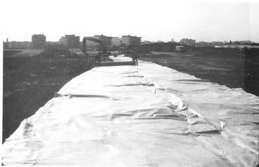
Figur 4:4 Utrullning av fiberduk på testyta C1-C4.
