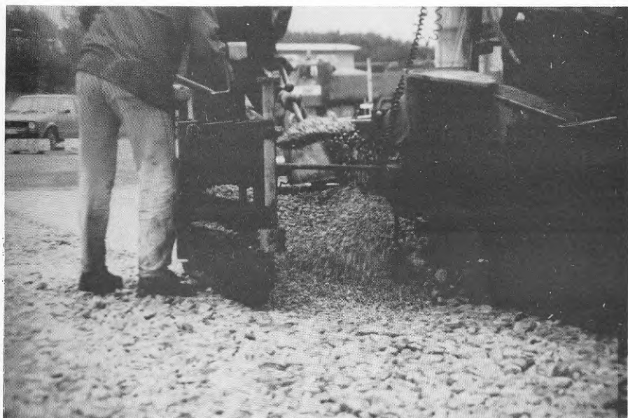
Figur 5:11 Justering av avjämningslager med hjälp av asfaltutläggare.
