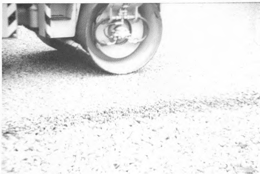
Figur 5:12 Packning av justerat avjämningslager.
