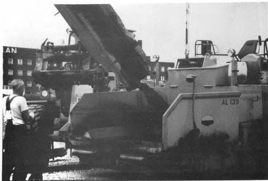
Figur 4:7b Tipping av massa i tråg vid omlastning med hjälp av traktor.
