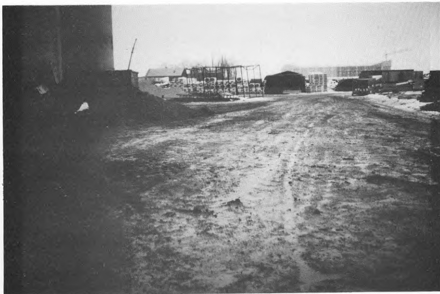
Figur 4:22 Testyta C1 och C2 under byggnadstiden.
