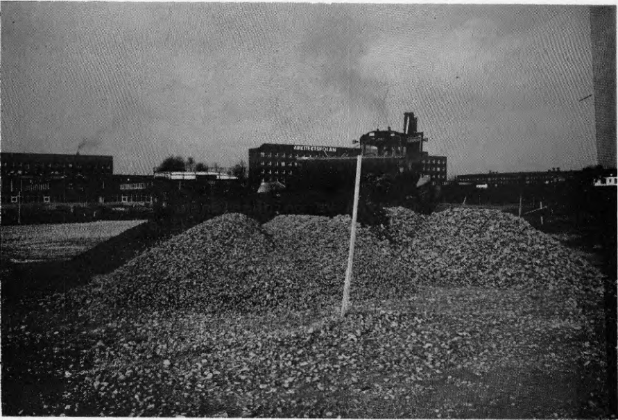
Figur 4:5 Sammanblandning av makadam till bärlager av tre olika fraktioner på platsen.
