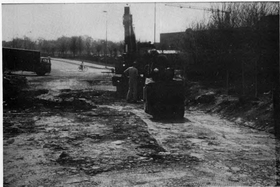
Figur 5:5 Packning av terrassen efter finterrassering.
