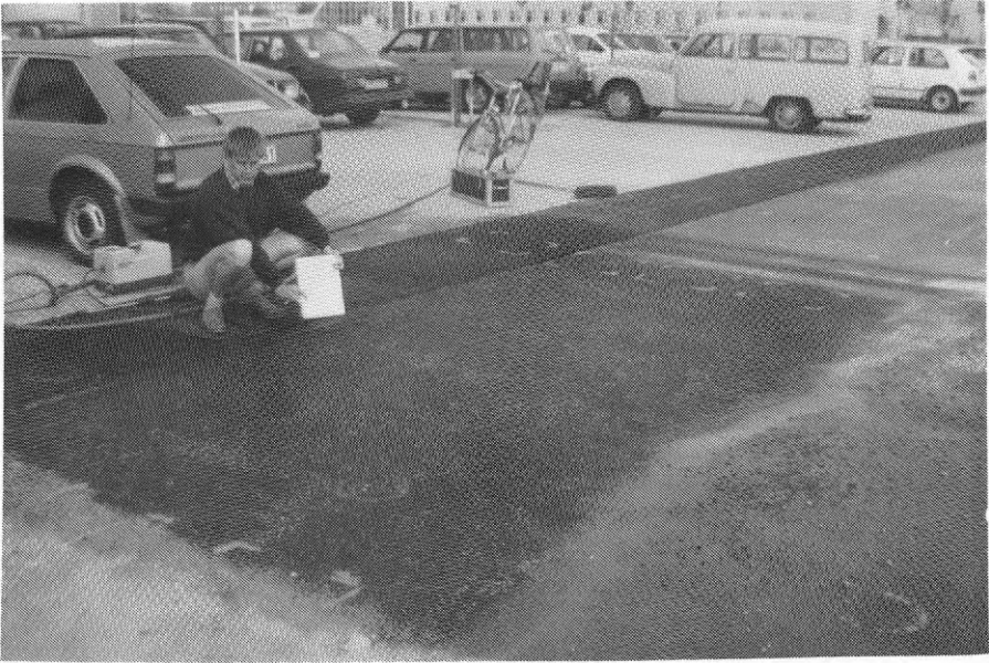
Figur 7.7:4 Resultat av renspolning på yta C1 inom Ideon, Lund. Observera lösspolat sediment utanför den rengjorda ytan.
