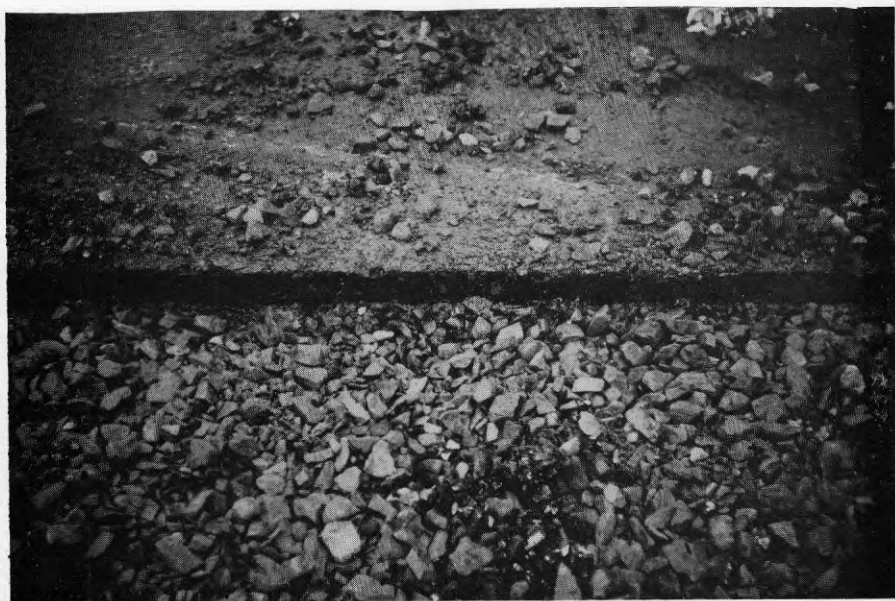
Figur 7.6:11b Uppgrävning av yta C1. Beläggning nedsmutsad av oljespill samt överyta makadambärlager.
