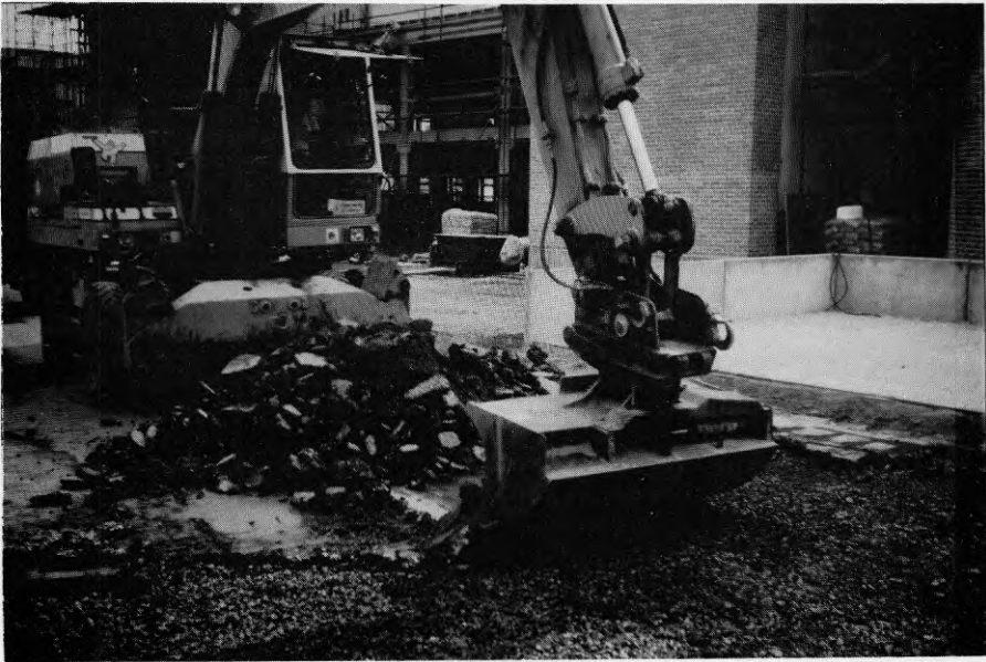
Figur 4:9 Upprivning av beläggning (HABD) på yta C1.
