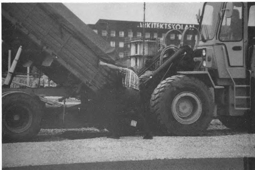
Figur 4:7a Omlastning av asfaltmassa till traktorlastare
