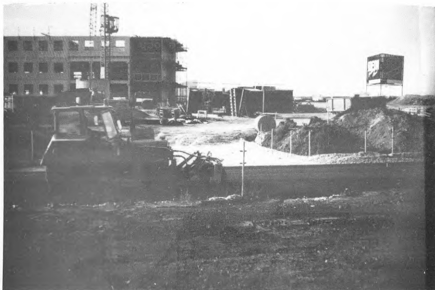
Figur 7.7:1 Avlägsnande av löst sittande föroreningar med hjälp av roterande borste.
