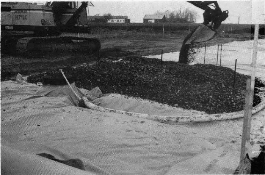
Figur 4:6 Påförande av makadam över mättrör.
