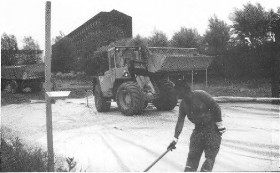
Figur 5:7 Utrullad fiberduk på Ole Römers väg.
