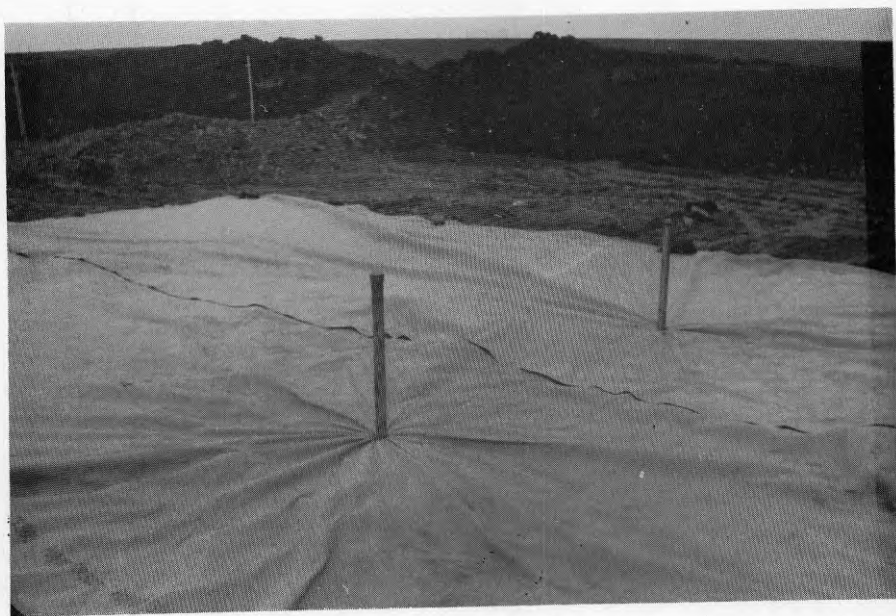
Figur 4:17 Markvattenrör av galvaniserade stålror.
