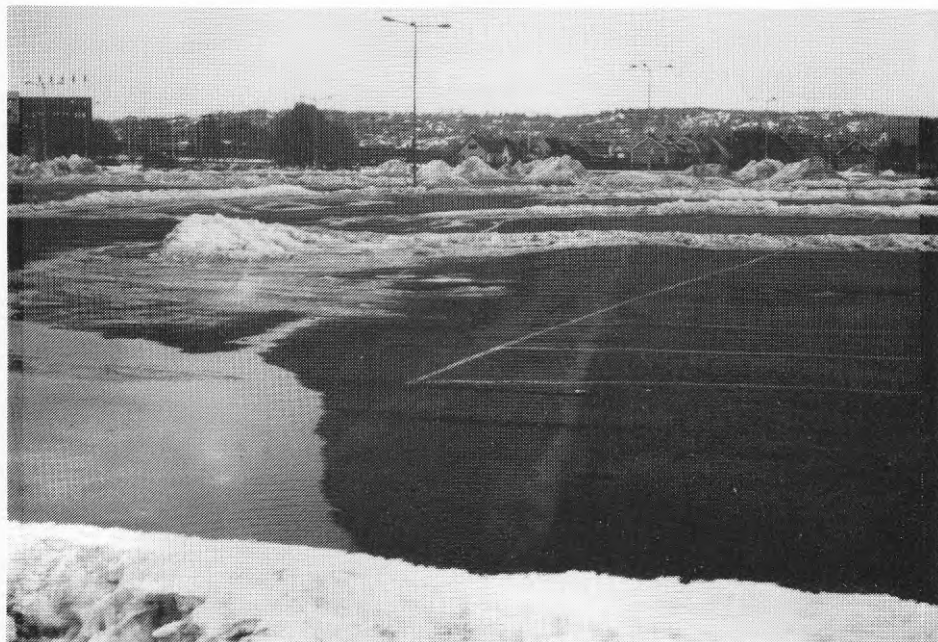
Figur 1:2 Skillnad i ytavvattning under snösmältning mellan en yta med tät asfalt (till vänster i bilden) och en yta med enhetsöverbyggnad (till höger). Parkeringsplats intill Åby travbana i Mölndal.
