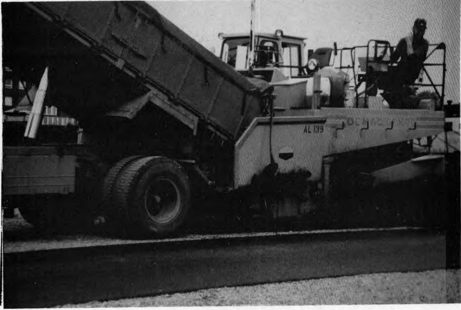
Figur 4:8 Direkt tippning av massa från lastbilen till utläggaren.
