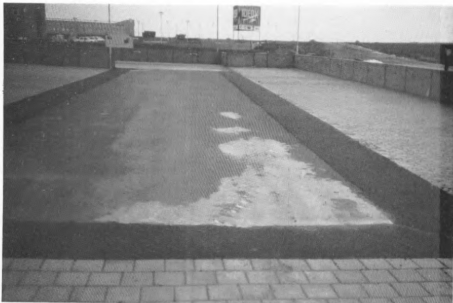
Figur 4:11 Justerade kanter på ytorna C3 och C4 mot intilliggande betongstensbeläggning.
