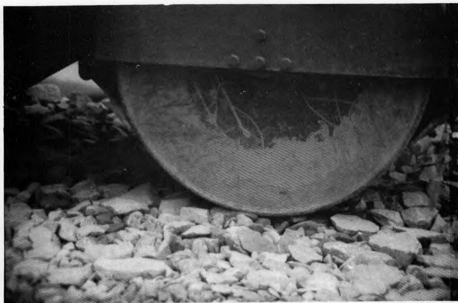
Figur 5:10 Packning av makadamfraktion 18-70 mm med slätvals-vält på Ole Römers väg.
