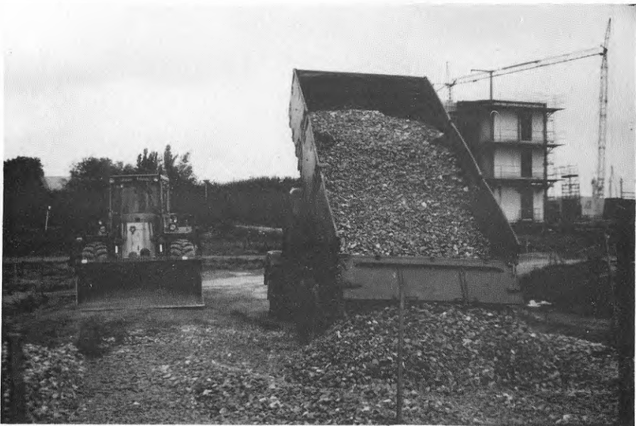
Figur 5:8 Ändtippning av makadam från lastbil på Ole Römers väg.
