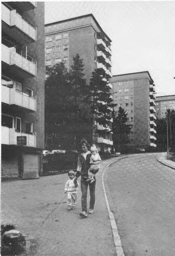
Bild 3 och 4. Många olika typer av bostadshus byggdes.
